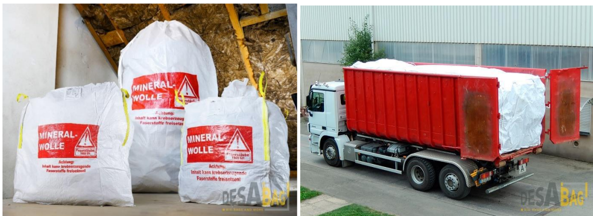
Abbildung 4: Verpackung von Mineralwolle-Abfällen [Quelle: Desa Group - www.desabag.de ]
