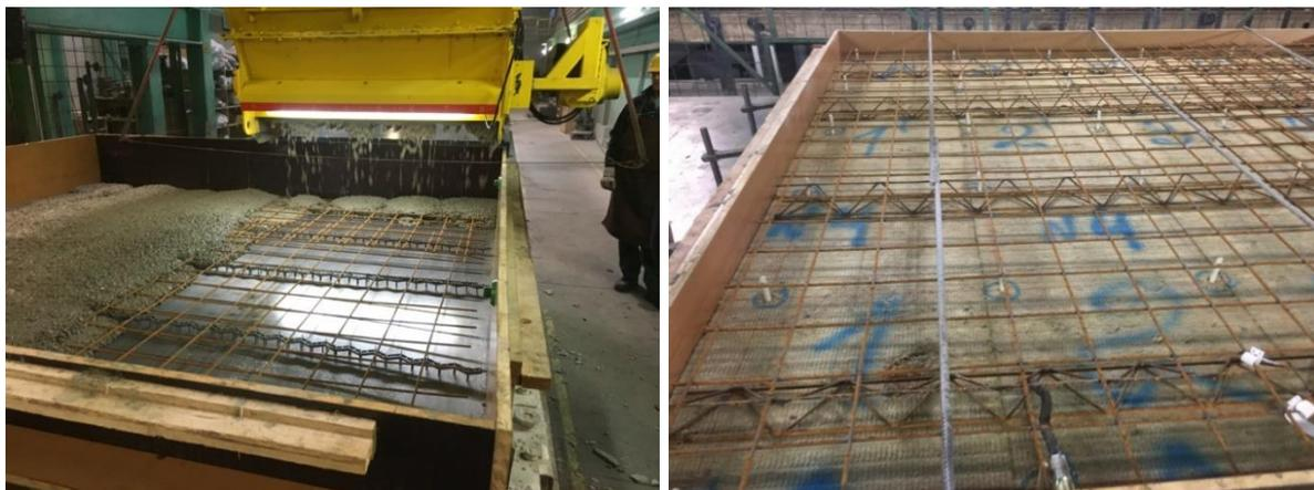
Abbildung 9: Herstellung von Sandwichwänden; Betonierung der unteren Schale (links), Bewehrung und Verbindungsmittel bereit für die Betonierung der oberen Schale
