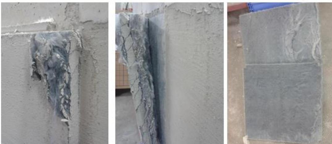
**Abbildung 62** Merkmale des selektiven Rückbaus für Material A.3. Links: Ablöseversuch der oberen Mörtelschicht an einer Ecke führt zu zerfransen des Produkts. Mitte: Ablösen bis zum hier dargestellten Wandabstand mit Schaber, anschließend per Hand abziehen. Rechts: Rückseite der abgelösten Elemente; oben wurde bis zur Mitte mit dem Schaber abgelöst, es sind Auswirkungen am Material zu erkennen. Die untere Matte wurde nach Randablösung per Hand abgezogen.
