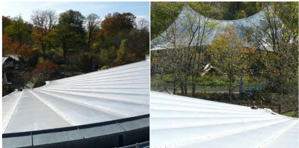
Bild 40: Dachkonstruktion des Schildkrötenhauses im Tierpark Hellabrunn [17].
