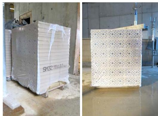
**Abb. 18** Einzellagerung auf der Baustelle (foliert, für Witterungsschutz) vor Deckenherstellung
