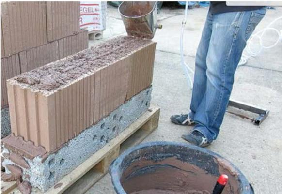
**Abb. 15** Videostandbild – Auftrag mit Mörtelwurf-spritze
