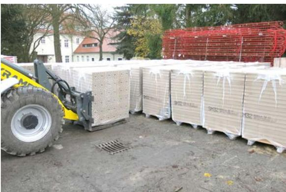
**Abb. 17** Lagerung der Steinpaletten im Gelände der Baustelleneinrichtung mit Folierung als Witterungsschutz
