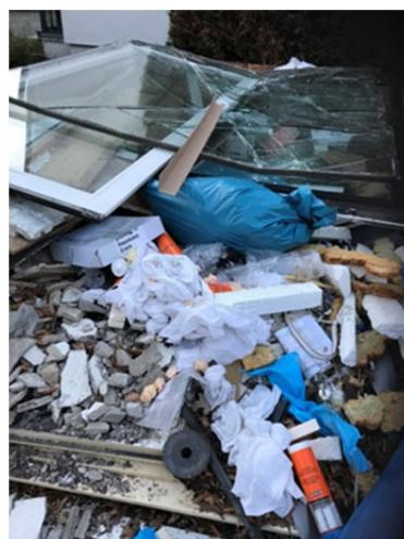
**Abbildung 12** Isolierglas in Baumischabfallcontainer
