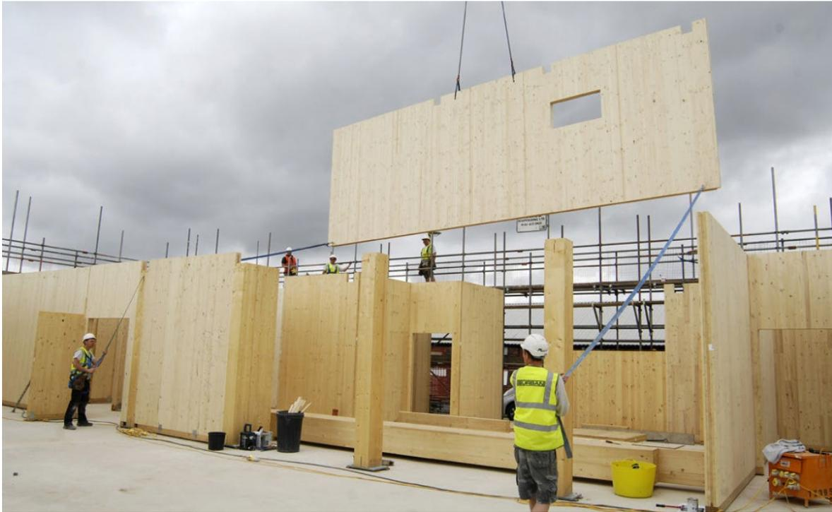
Abb. 7: Beispiel für CLT „Plattentektonik“.
