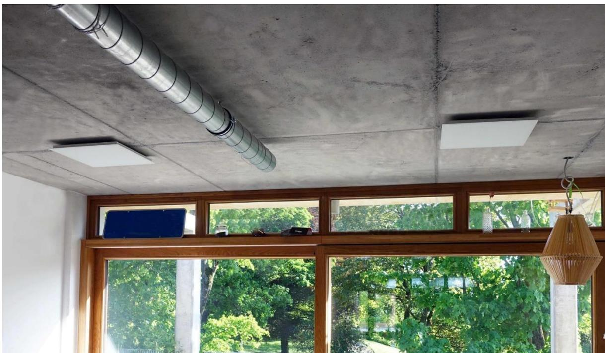
Abb. 13 Infrartheizungen K76 links und rechts sowie Lüftungsleitung
