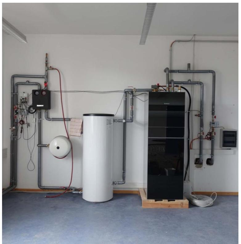
Abb. 42 Technikraum für Wärmepumpe mit Pufferspeicher
