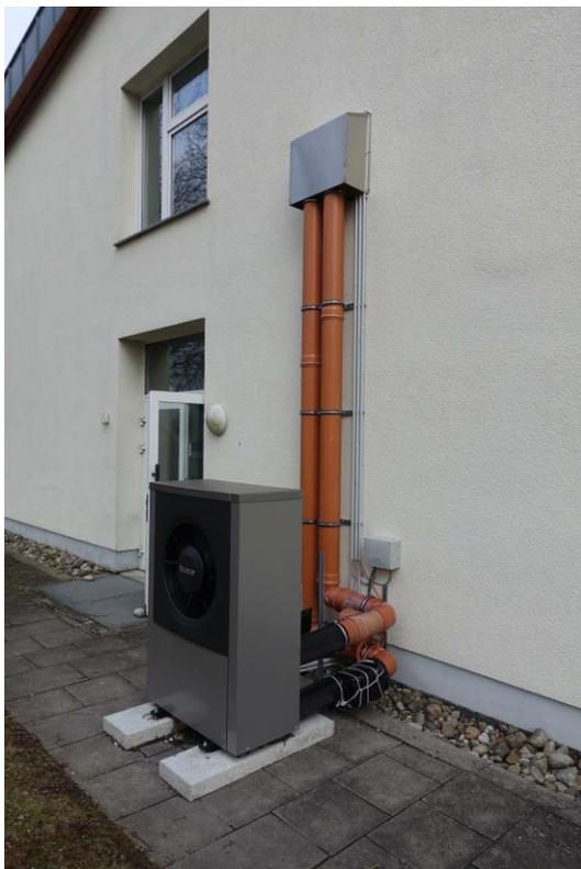
Abb. 43 Luft/Wasser-Wärmepumpe
