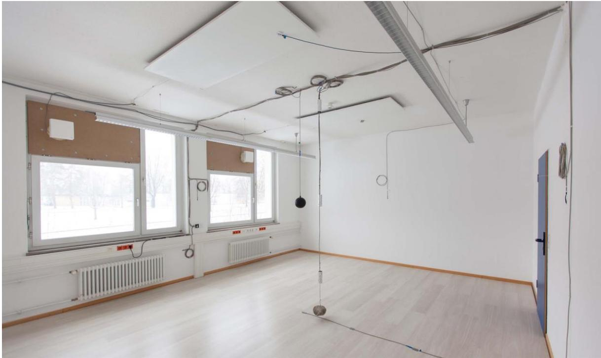
**Abb. 45 Laborraum T3 mit IR-Heizung an der Decke**
