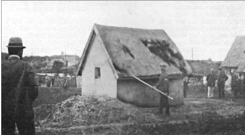
**Abbildung 30:** Erste Brandprobe: Entzündung der äußeren Oberfläche des Lehm-schindeldaches<sup>214</sup>
