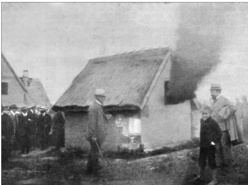
**Abbildung 32:** Dritte Brandprobe: Feuer im Inneren des Häuschens bei starker Rauchbildung<sup>216</sup>
