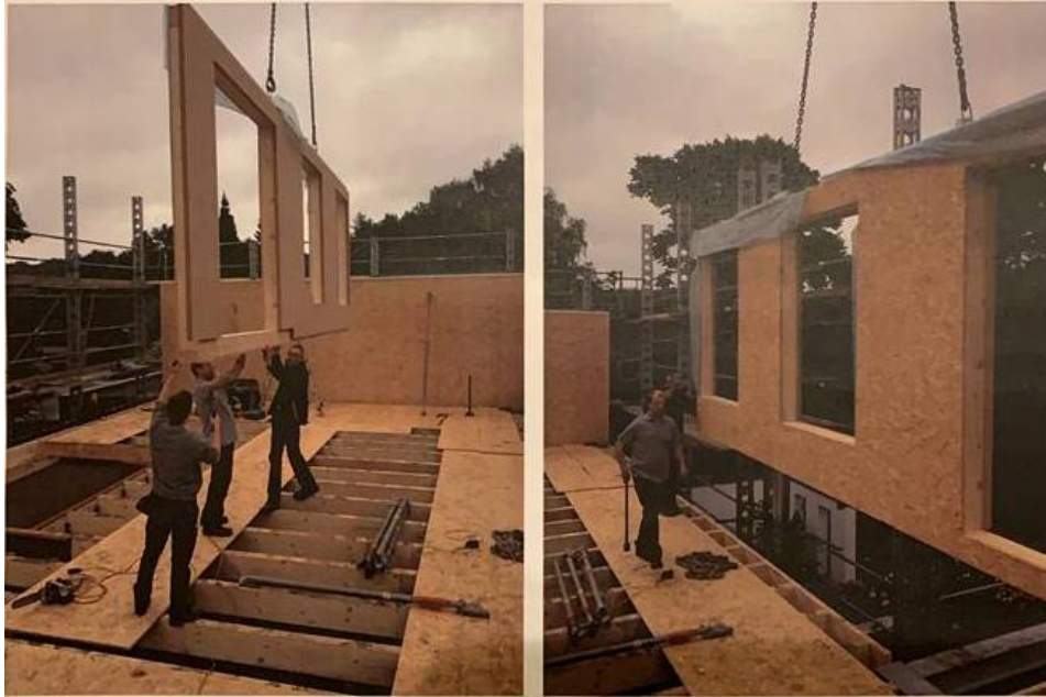
Abbildung 12: Errichtung der Innen- und Außenwände in Holzrahmenbauweise mit innen- und außenseitiger OSB-Bekplankung
