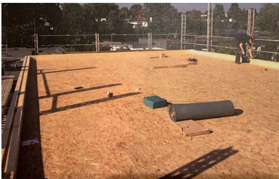
Abbildung 11: Herstellung des Fußboden-Unterbodens mit OSB-Platten
