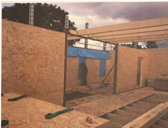
Abbildung 13: Herstellung des Dachaufbaus mit Holzbalken
