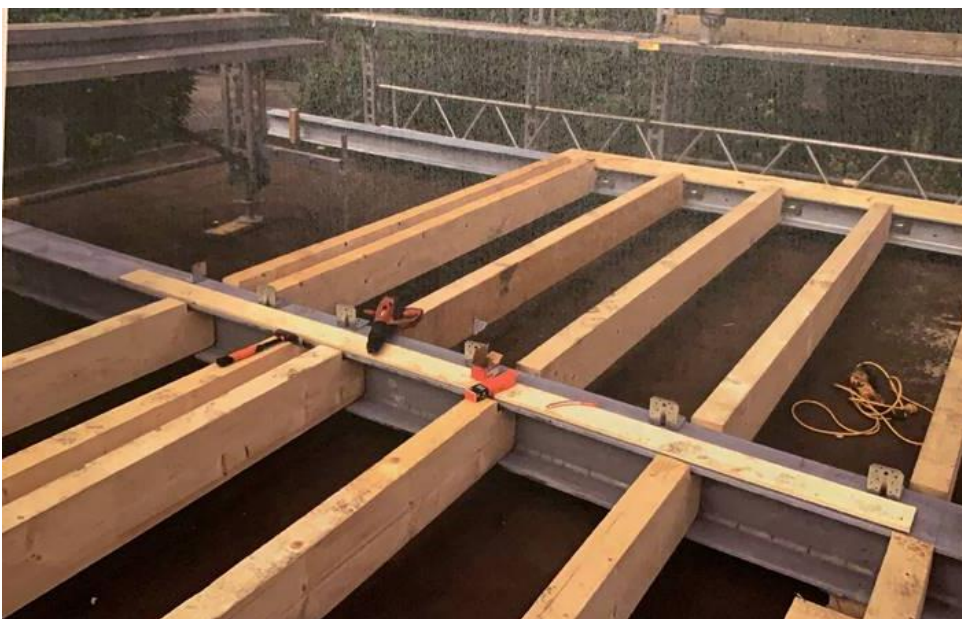
Abbildung 10: Errichtung der Aufstockung auf dem vorhandenen Flachdach
