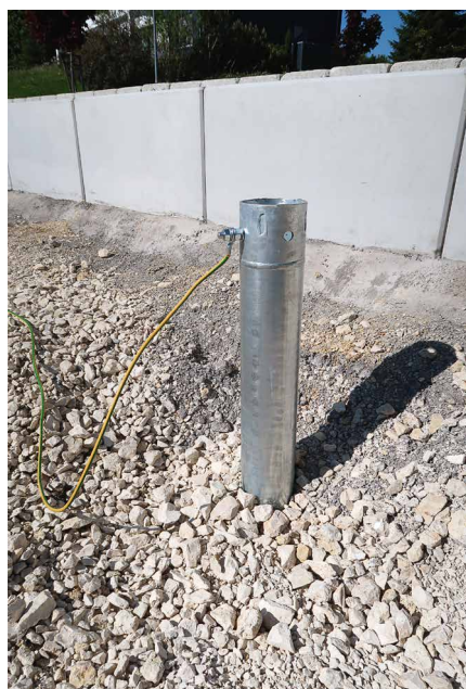
Abb. 4: Schraubpfahlfundament aus feuerverzinktem Stahl
