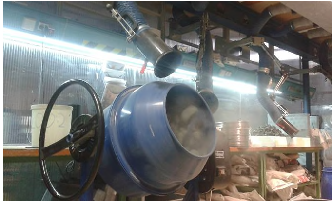
Bild 3: Trommelmischer zur Vorbehandlung des Schaumglas.
