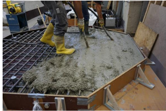
d) Verdichten des Betons
