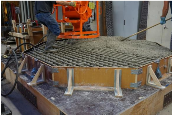
c) Einbau des Betons
