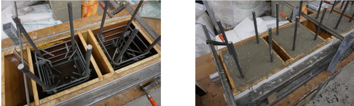
Abbildung 3.7: Schalung mit Bewehrung der Stützenabschnitte (links) sowie betonerte Stützenabschnitte (rechts)
