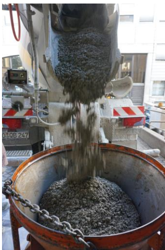
a) Anlieferung des Betons
