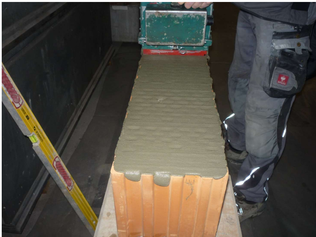
Bild 23: Mörtelauftrag des maxit mur 900d bzw. DBM (T) mit Mörtelschlitten (PlanHLz B)
