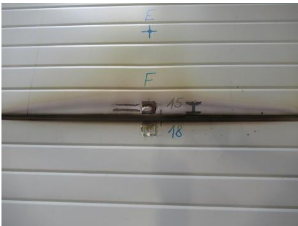
Abb. 10.12: Fuge von außen
