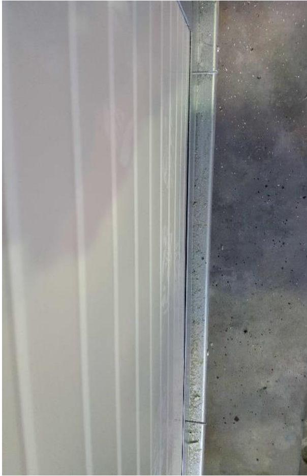
Abb. 7.7: Anschluss unten mit Spalt (18')
