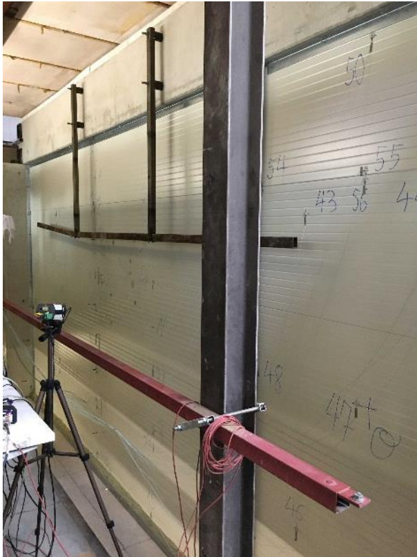
Abb. 6.1: Wandaufbau vor Versuch
