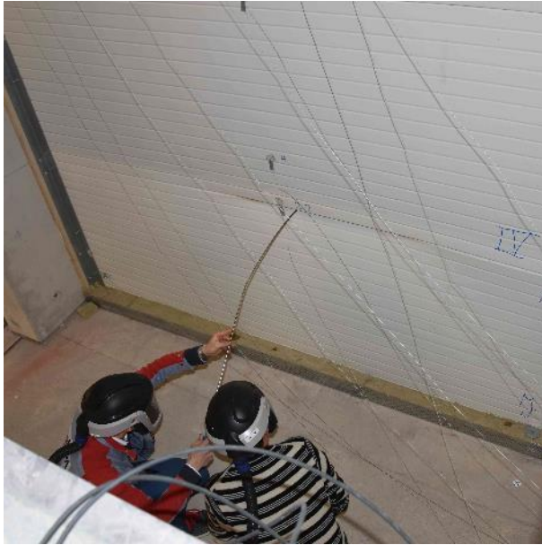
Abb. 8.25: Überprüfung Fuge an Mst 22 (119')
