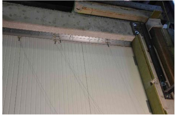
Abb. 12.2 Deckenanschluss und freier Rand
