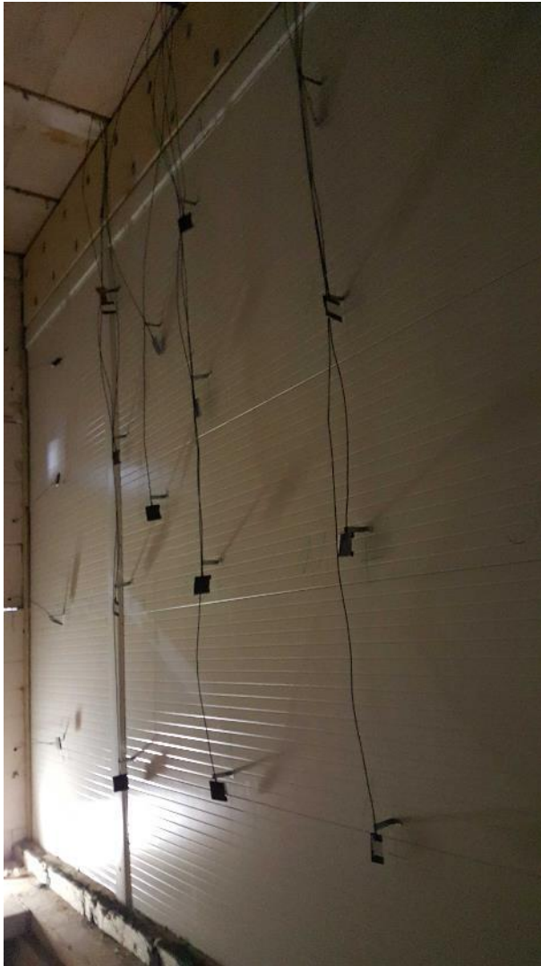
Abb. 6.5: Innenansicht Felder mit Fuge
