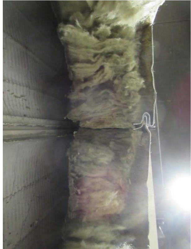
Abb. 14.10: Fugenpassung oben
