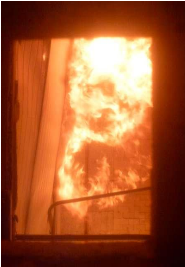
Abb. 12.3: Fugen schwarz verfärbt und in den Brandraum gewölbt (4')
