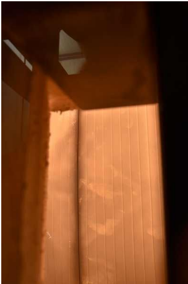
Abb. 11.3: Dunkelfärbung an den Stoßfugen (3')
