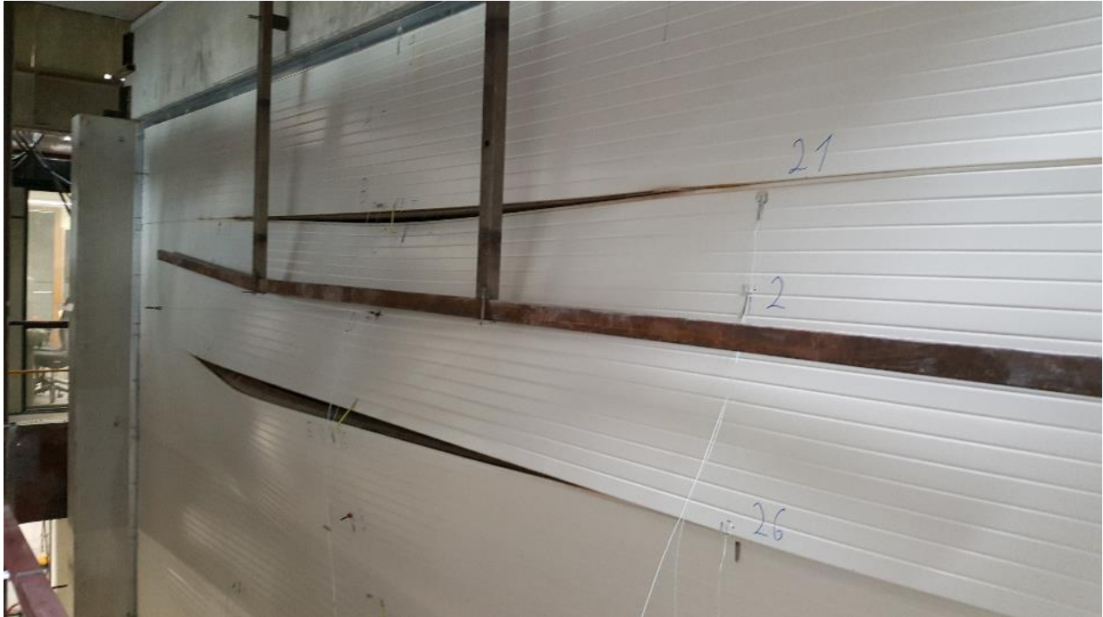
Abb. 5.25: Verformung nach Versuchsende
