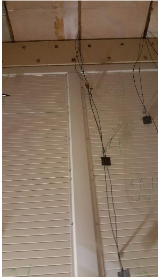
Abb. 6.6: Fugenabdeckung innen
