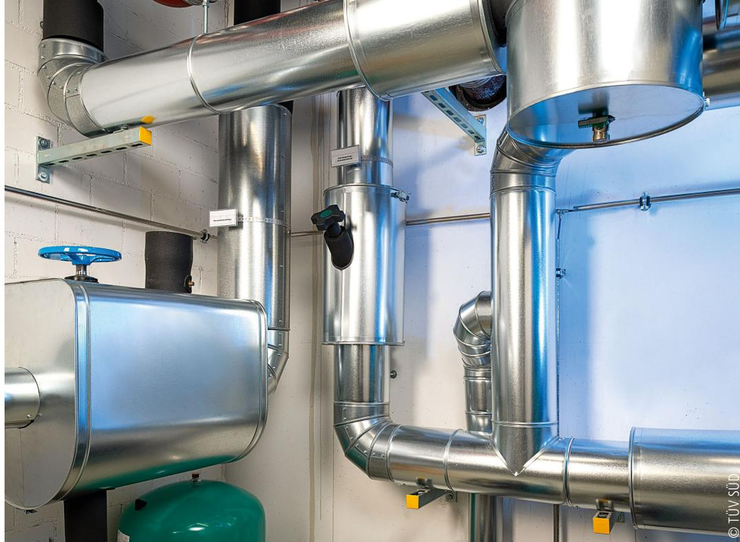
Abb. 1: Rohre, Armaturen und Speicherbehälter dürfen nur so viel Trinkwasser enthalten, wie für die Versorgung technisch erforderlich ist
