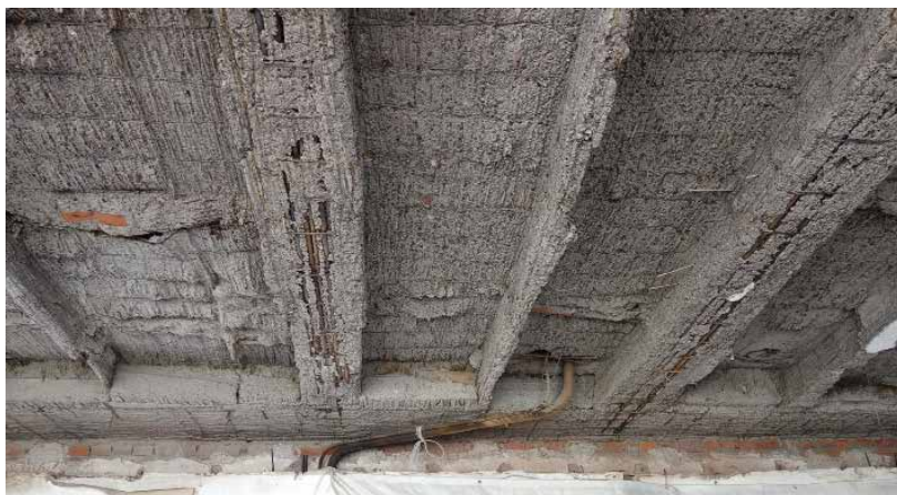
Abb. 14: Wayss'sche Rohrzellendecke (links) mit auflagernahem Schubriss (rechts)
