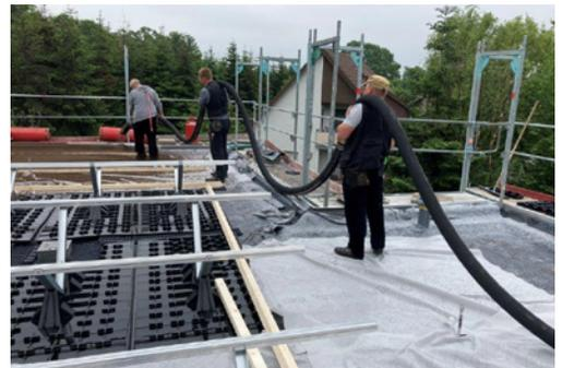
**Abb. 02:** Das Substrat für die extensive Begrünung wird per Druckluft auf die Dachfläche geblasen.
