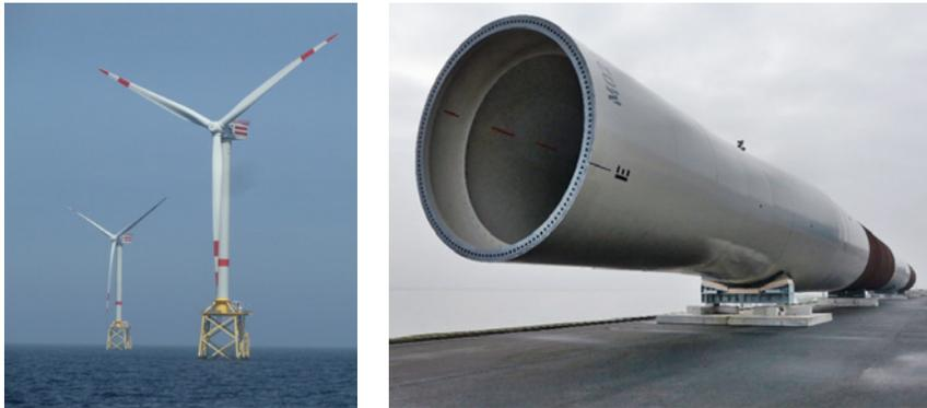
**Abb. 01:** Links – Offshore Windenergieanlage mit Jacket-Gründungsstruktur aus dem Windpark alpha ventus [Foto: Institut für Stahlbau, LUH]; rechts – Monopile bei Steelwind, Nordenham [Foto: Peter Schaumann]
