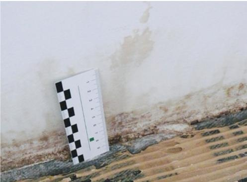
**Abb. 03:** Detailansicht des beschädigten Innenputzes in einem Wohnraum
