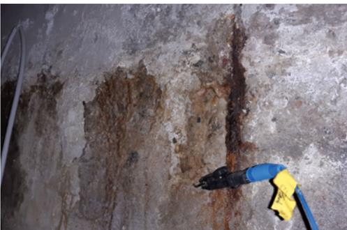
**Abb. 06:** Einspeisung / Tracer im Außenwandbereich [Quelle: Texplor GmbH]
