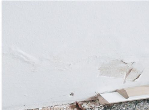
**Abb. 02:** Detailansicht des beschädigten Innenputzes in einem Wohnraum
