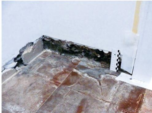
**Abb. 04:** Detailansicht des beschädigten Natursteinbelags im Treppenhaus
