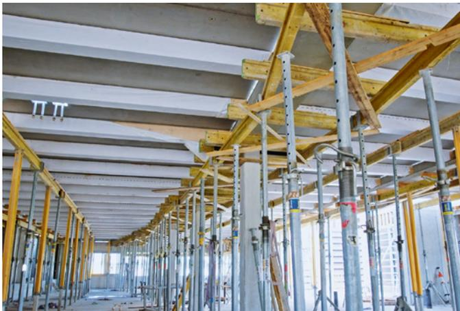
**Abb. 02:** Vorgefertigte Holz-Hybriddecke mit oberflächennaher Bauteilaktivierung und Reduktion des CO<sub>2</sub>-Footprints um 60 Prozent
