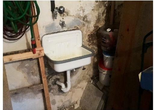
**Abb. 05:** Teilansicht der feuchtegeschädigten Kelleraußenwand aus Abb. 04
