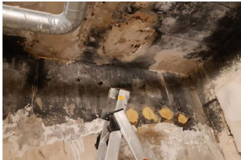
**Abb. 05:** Deckenbereich mit Feuchtigkeitsschäden [Quelle: Texplor GmbH]
