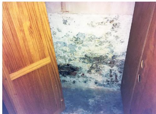
**Abb. 03:** Kelleraußenwand mit Putzabplatzungen und Salzausblühungen
