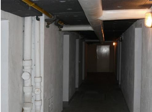
**Abb. 01:** Kellerdecke mit der nachträglich angebrachten Wärmedämmung
