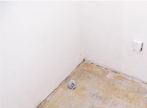
**Abb. 01:** Teilansicht des beschädigten Innenputzes in einem Wohnraum
