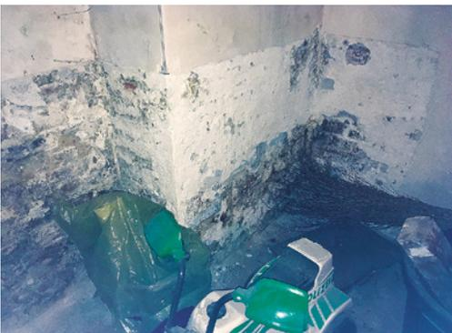
**Abb. 02:** Kelleraußenwand mit Farb- und Putzabplatzungen
