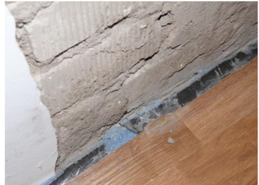
**Abb. 06:** Teilweise entfernter Innenputz in einem Wohnraum
