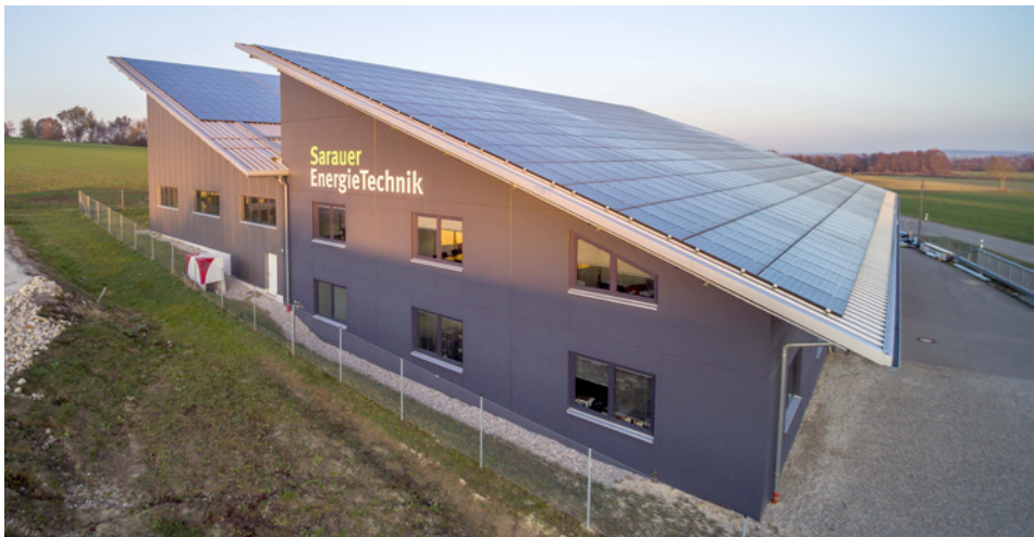
Abbildung 2: Foto: Sarauer Energietechnik, Pöttmes
