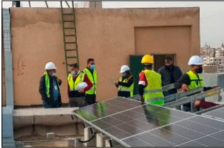
Abbildung 3: Begutachtung einer PV-Anlage [Foto: GFA Consulting Group GmbH]
