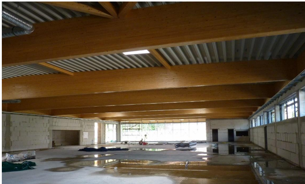
Abb. 105: Bauvorhaben 2021-KW30_1 zum Zeitpunkt der Messung
