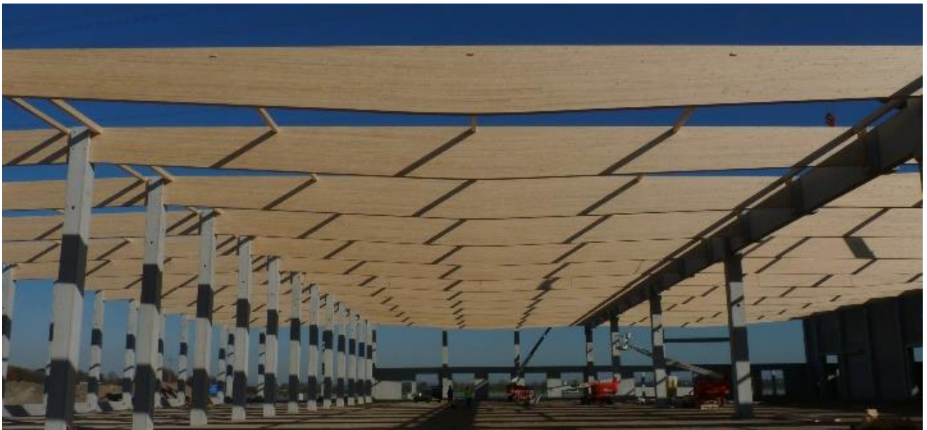
Abb. 81: Bauvorhaben 2020-KW45_1.2 zum Zeitpunkt der Messung
