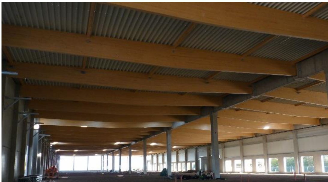
Abb. 76: Bauvorhaben 2020-KW45_1.1 zum Zeitpunkt der Messung
