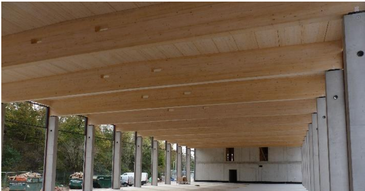
Abb. 58: Bauvorhaben 2020-KW38_1.1 zum Zeitpunkt der Messung
