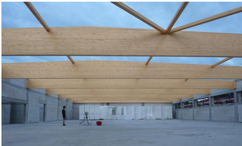
Abb. 111: Bauvorhaben 2021-KW30_3 zum Zeitpunkt der Messung
