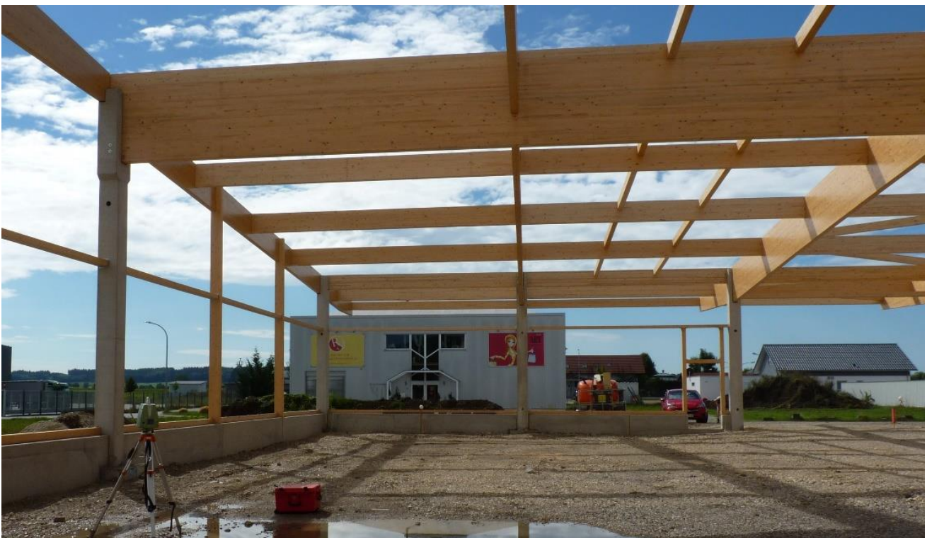
Abb. 3: Aufbau Laserscanner, Bauvorhaben 2020-KW34.
