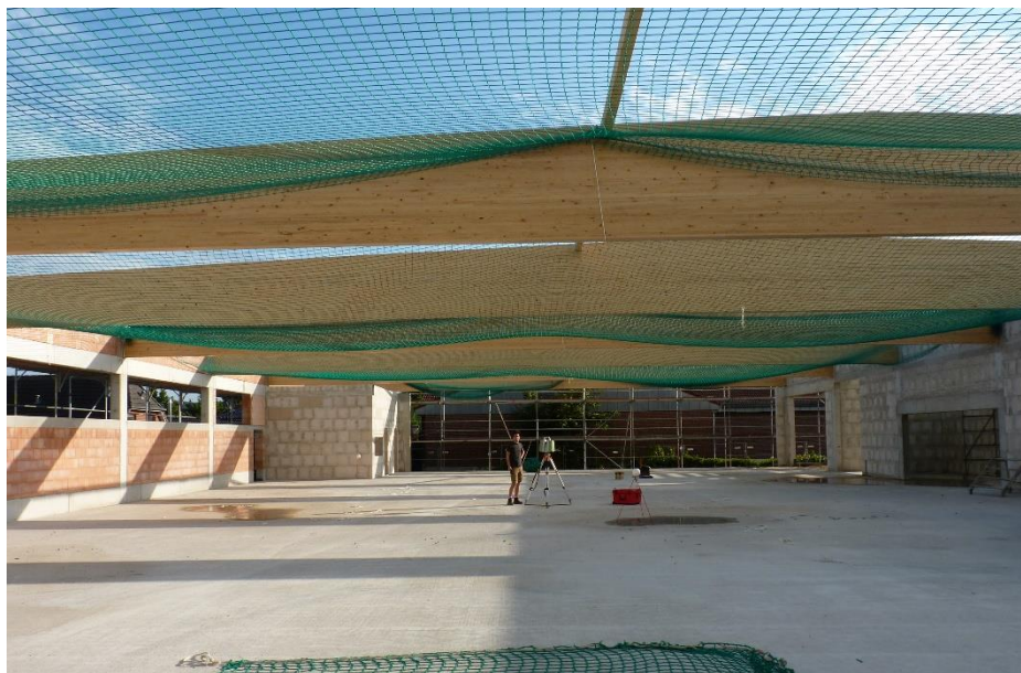
Abb. 108: Bauvorhaben 2021-KW30_2 zum Zeitpunkt der Messung
