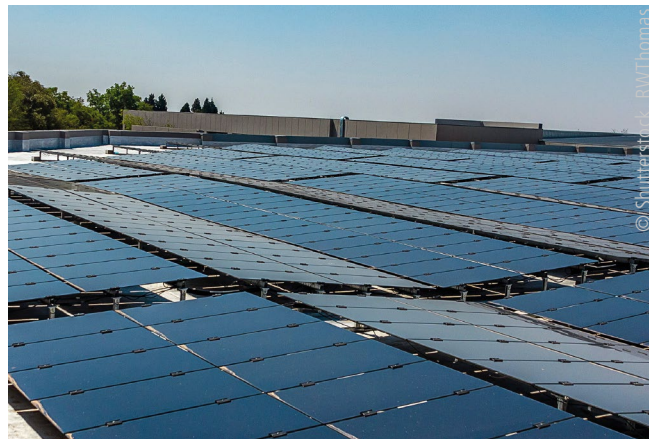
Abb. 3: Solarpaneele, die auf Dächern aufgestellt werden (BAPV – Building Attached PV), werden nicht als Bauprodukte betrachtet, sondern unterliegen der Niederspannungsrichtlinie
