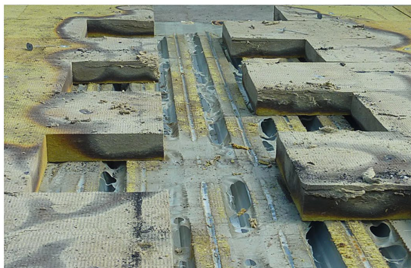
Abb. 11: PU-Dach, Dampfsperre unbeschädigt (links) und MW-Dach, Dampfsperre teilweise geschmolzen (rechts).
