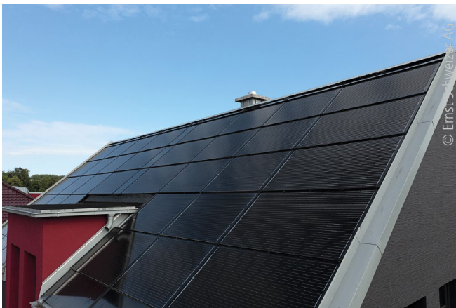
Abb. 2: Einfamilienhaus in Wittmund mit gebäudeintegrierten PV-Modulen (BIPV – Building Integrated PV)
