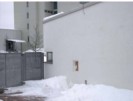
Abb. 1: Schnee vor der Hauswand, deutlich höher als der Sockelputz mit 30 cm Höhe
