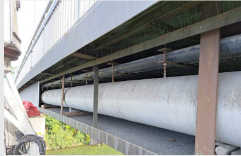
Abb. 02: Mithilfe eines Brückenuntersichtgeräts wurden die Gasleitungen (2x DN 400) auf ihren Zustand geprüft. Hierfür wurde die Blechverkleidung an mehreren Stellen demontiert. Im Zuge dieser Prüfung konnten die Auflager und Rohrteile einer Sichtprüfung unterzogen werden. [Foto: Netze BW GmbH]
