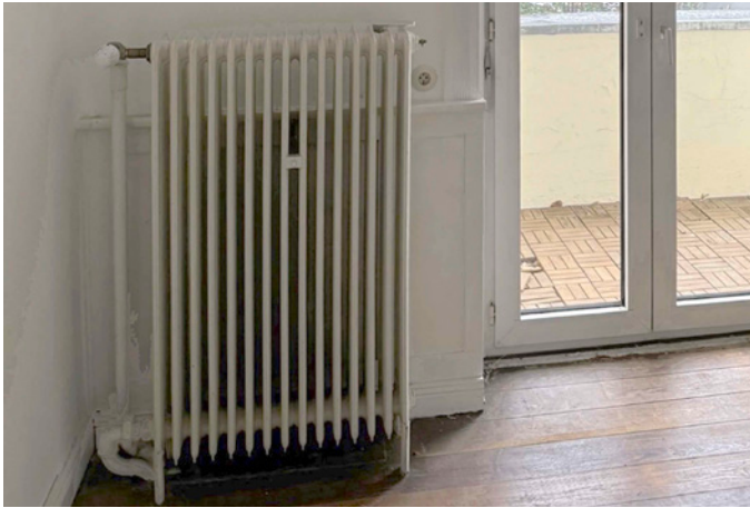
Abb. 03: Bestehender Heizkörper (Gussradiator)
