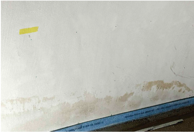
Abb. 08: Kellerwand mit Messpunkten für die Feuchtemessung
