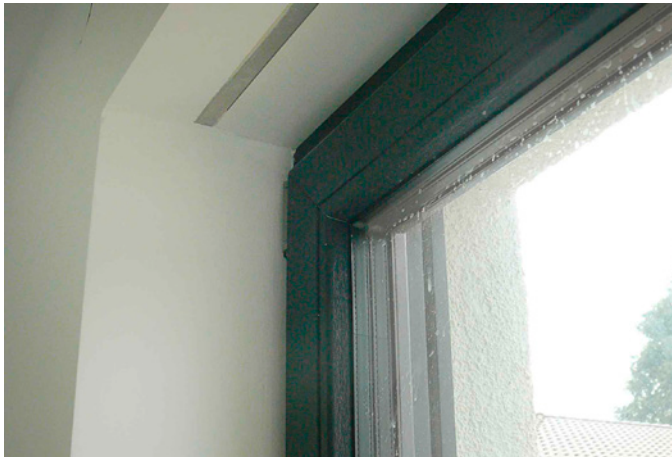
Abb. 01: Neu eingebautes Fenster mit Dreifachverglasung
