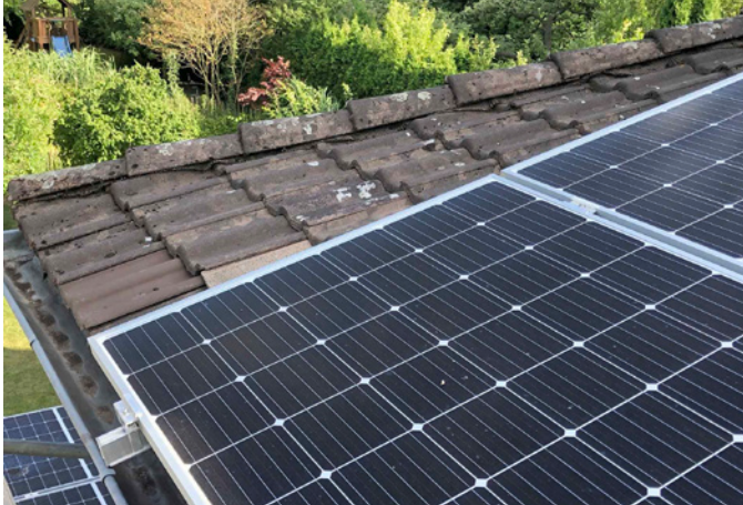
Abb. 01: Teil der PV-Anlage auf dem Hauptdach
