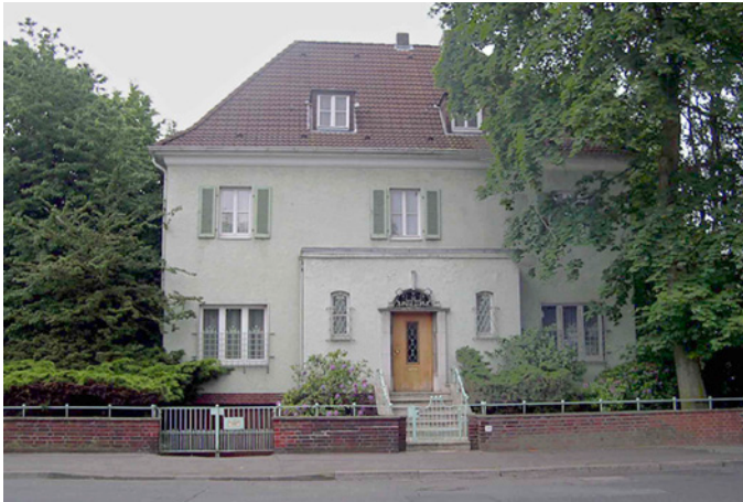
Abb. 01: Das Einfamilienhaus im unsanierten Zustand
