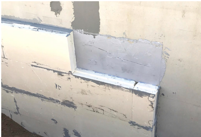
Abb. 04: Vollflächig aufgebrachte Klebermasse auf der Kelleraußenwand
