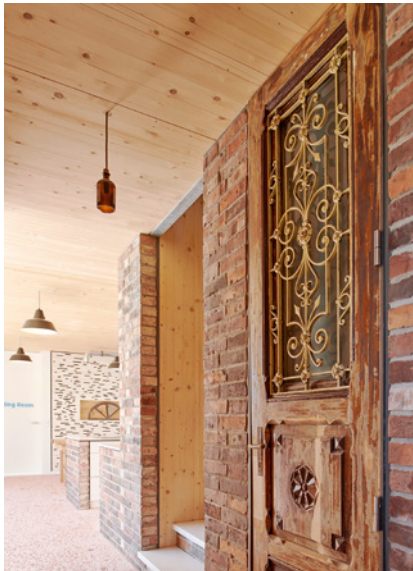
Abb. 04: Innenwände aus Abbruchziegeln [Foto: © Olaf Mahlstedt]
