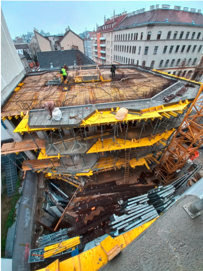
Abb. 04: Verlegung der Bauteilaktivierung im Rohbau [Foto: © zeininger architekten]
