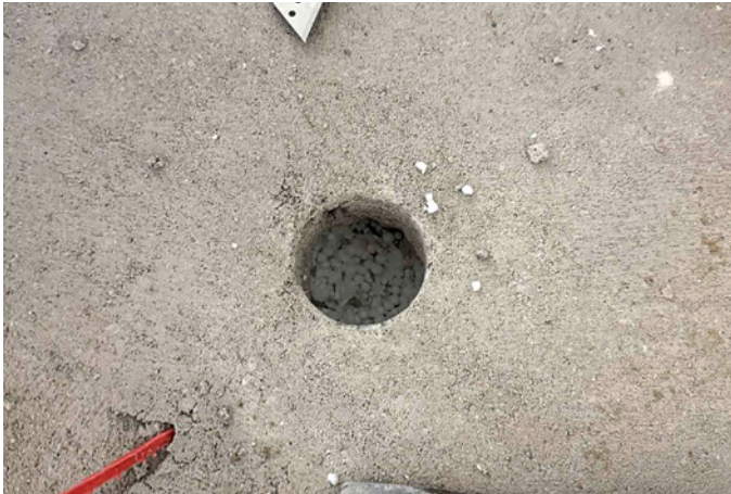
Abb. 04: Bohrung im Fußbodenaufbau für Probenahme
