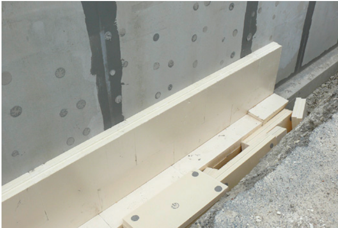
Abb. 02: Punktweise verklebte Perimeterdämmung
