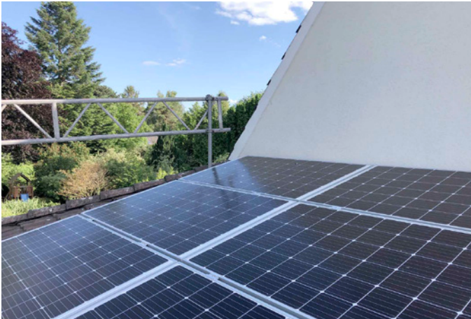
Abb. 04: Verschattete PV-Module
