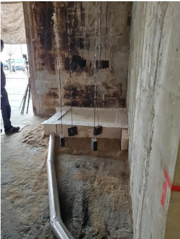
Abb. 7-27: Nach der 2. Lage Kalziumsilikatplatten wird der Rand mit Keramikwolle überklebt.
