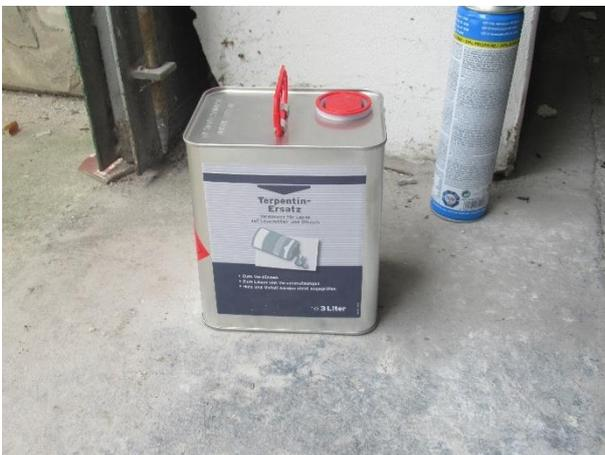
Abb. 7-17: Zum Tränken der Holzweichfaserplattenstreifen wird Terpentinersatz verwendet.
