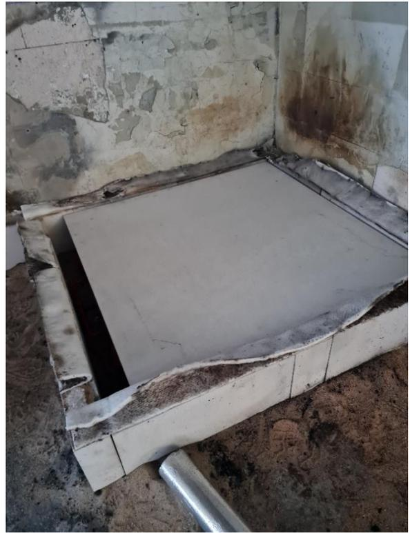
Abb. 7-26: Die Palettenwaage wird mit der 1. Lage Kalziumsilikatplatten abgedeckt.
