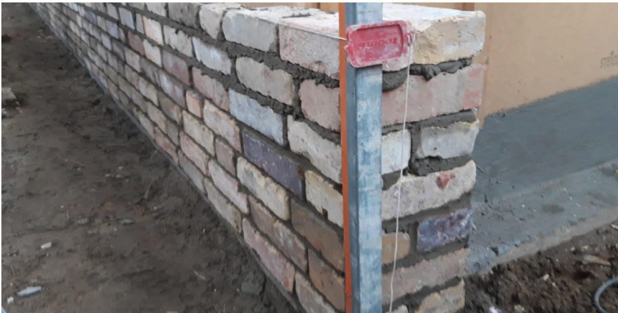
Abbildung 4: Hinterlüftetes Verblendmauerwerk aus wiederverwendeten Mauerziegeln (Foto: Spreeplan Projekt UG)
