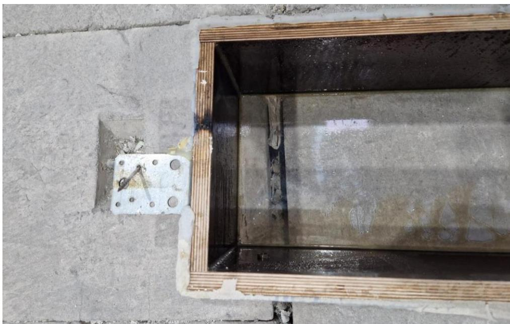
Abb. 6.106: Verkohlung am RAK-Bauteilfuge sichtbar (nach Abbau)
