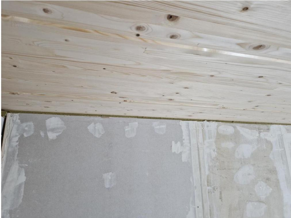
Abb. 6.252: Bauteilfuge mit komprimierter Mineralwolle (vor Versuchsbeginn)
