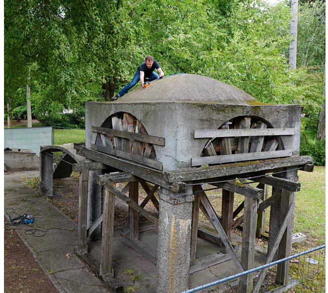
Abb. 5: DFG-Schwerpunktprogramm »Kulturerbe Konstruktion«. Zerstörungsfreie Erkundung der Stampfbetonskulpturen in Offenbach mittels Georadar. [© Nikolaus Koch]
