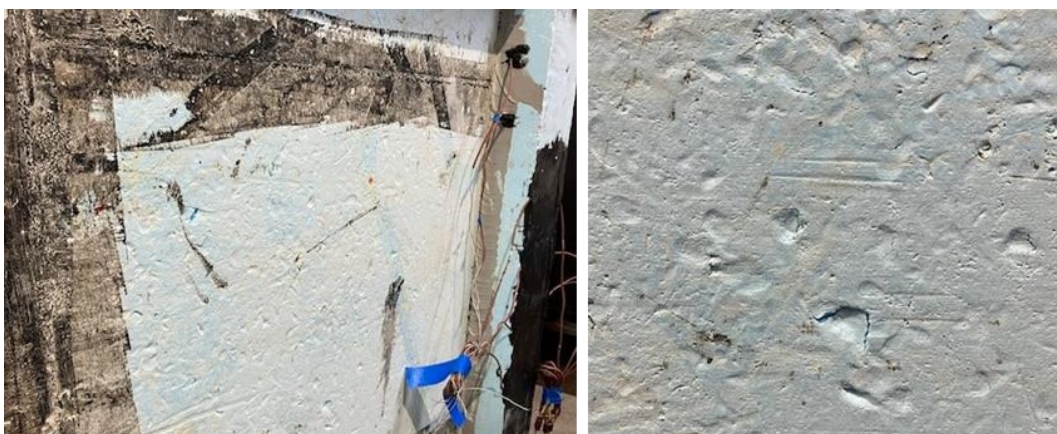
Abbildung 8 Links: Prüfkörper mit durch bituminösen Kleber gefüllten Fugen nach mehrwöchigem Einbau in eine Prüfkammer gemäß Kapitel 7; Rechts: Beschädigte Oberfläche mit Vertiefungen und gelegentlichen Rissen in der Deckschicht, verursacht durch Punktlasten des angrenzenden Erdreichs.
