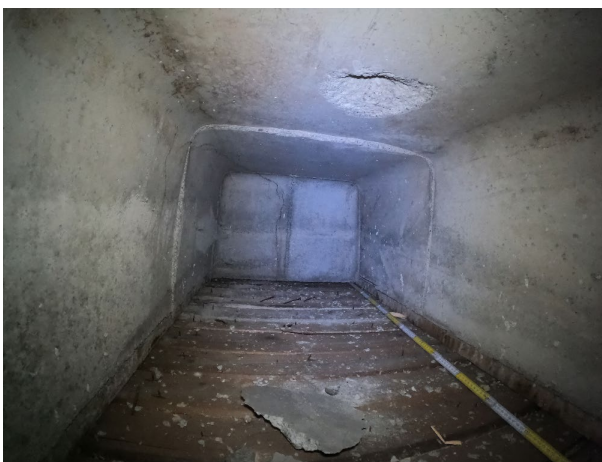
Abb. 10 Rippenzwischenraum: oben ein Ausbruch im Deckenspiegel, hinten links eine durchlaufende Schalfuge und Risse
