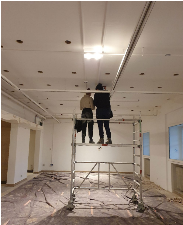
Abb. 9 Deckenuntersuchung im Saalbau des Deutschen Museums mittels Kernbohrungen durch KB+BM (Gapp GmbH, München)
