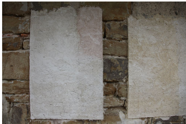
Abb. 9 Musterflächen mit unterschiedlichen Farbtönen bei gleicher Oberflächenbearbeitung – Geislingen an der Steige, Siechenkapelle, 2017 (AeDis AG)
