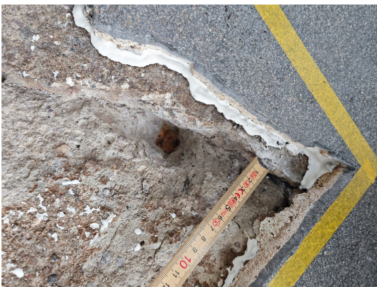
Abb. 13 ... und Erkundung der Deckenoberseite wäh- rend Reparaturarbeiten am Steinholzestrich (Stiftung Bauhaus Dessau)
