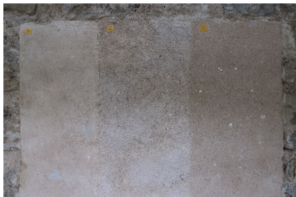
Abb. 10 Musterflächen mit unterschiedlichen Oberflächenstrukturen bei gleicher Mörtelmischung – Schwäbisch Hall, OT Steinbach, St. Johannes Baptist, 2023 (AeDis AG)
