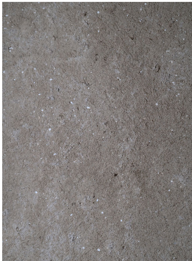
Abb. 3 Kalkspatzen in abgekelitem Fassadenputz – Geislingen an der Steige, Siechenkapelle, 2017 (AeDis AG)
