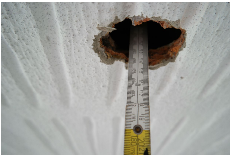
Abb. 12 Kalibrierungsöffnung an der Deckenunterseite ...
