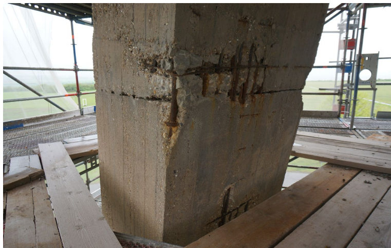
Abb. 2 Betonschäden an dem Sendeturm (Pfeiler P1, Gerüstebene 8), horizon- tale Betonierfuge und Schalbrettstoß
