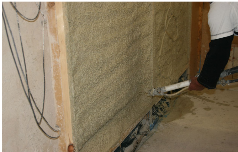
Abb. 10 Verarbeitung des Dämmputzes im Prüfstand
