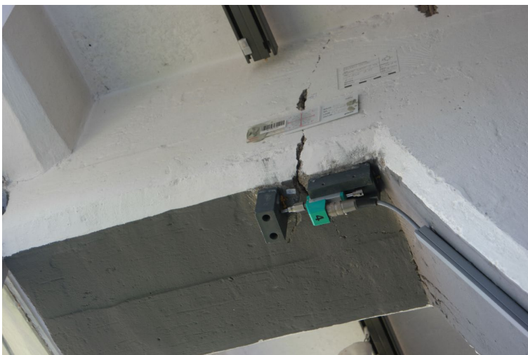
Abb. 3 Rissbildung an den Konsolen im Anschlussbereich der Vorhangfassade
