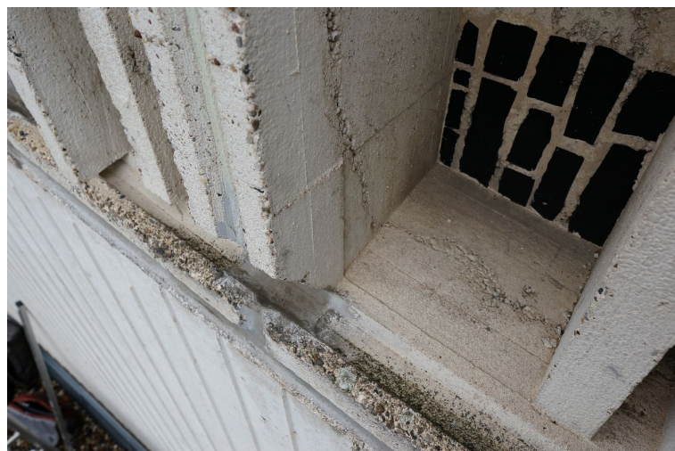
Abb. 15 Südfassade der Mauritiuskirche mit Herstellungsspuren. Die Abdrücke der Styroporschalung treten deutlich hervor. Unregelmäßige „Ent- mischungskanten“ kommen bei fast allen Elementen der Südseite vor.
