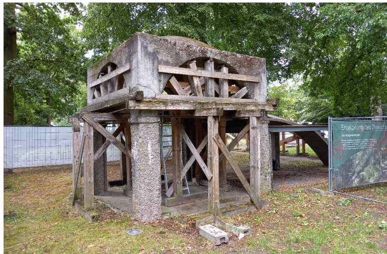
Abb. 17 Pavillon mit temporärer Stützkonstruktion
