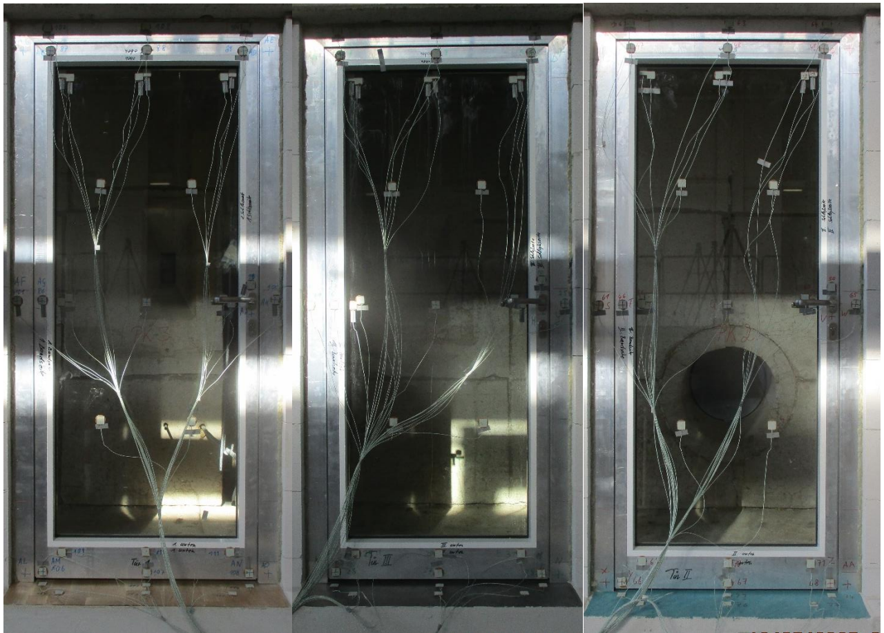
Abbildung 8: V 2 - Einbausituation der Prüfelemente
