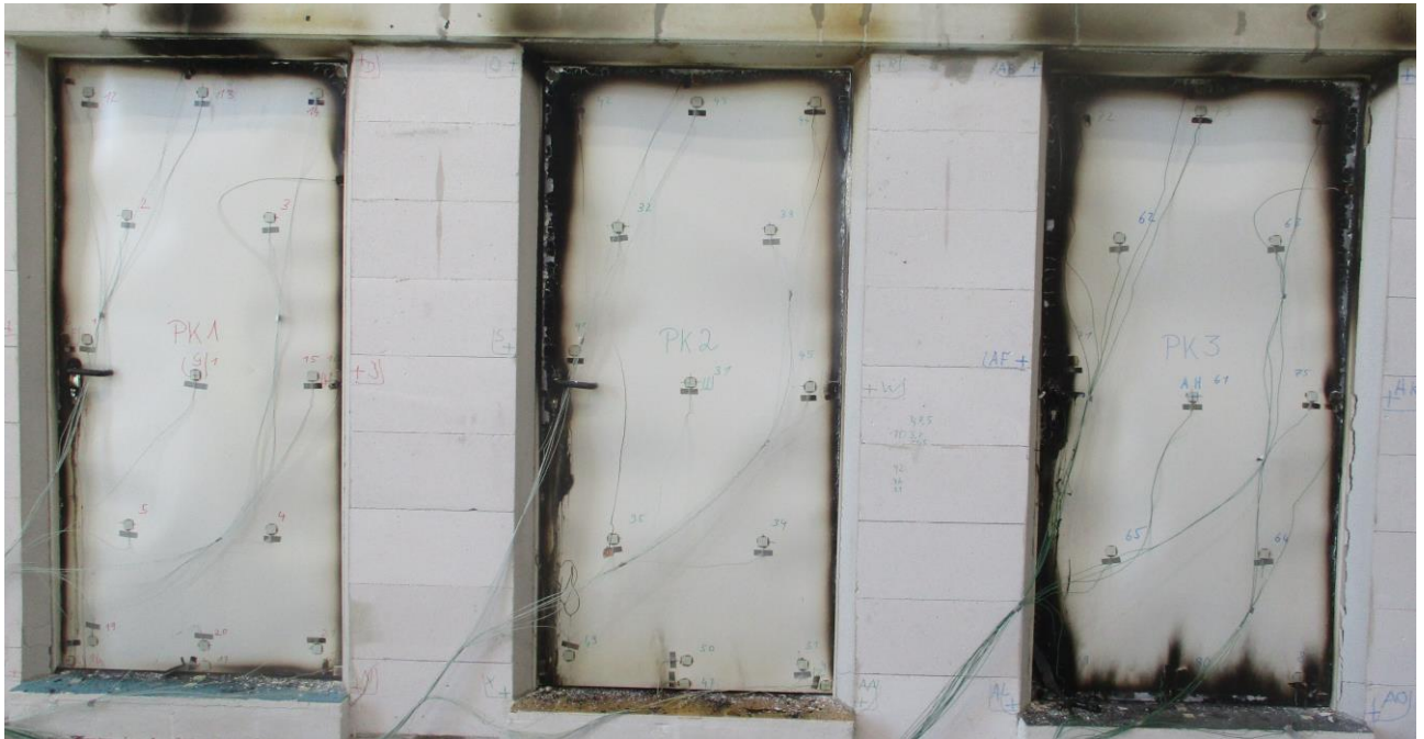
Abbildung 25: V 1 - Prüfelemente nach dem Brandversuch (unbeflammte Seite)
