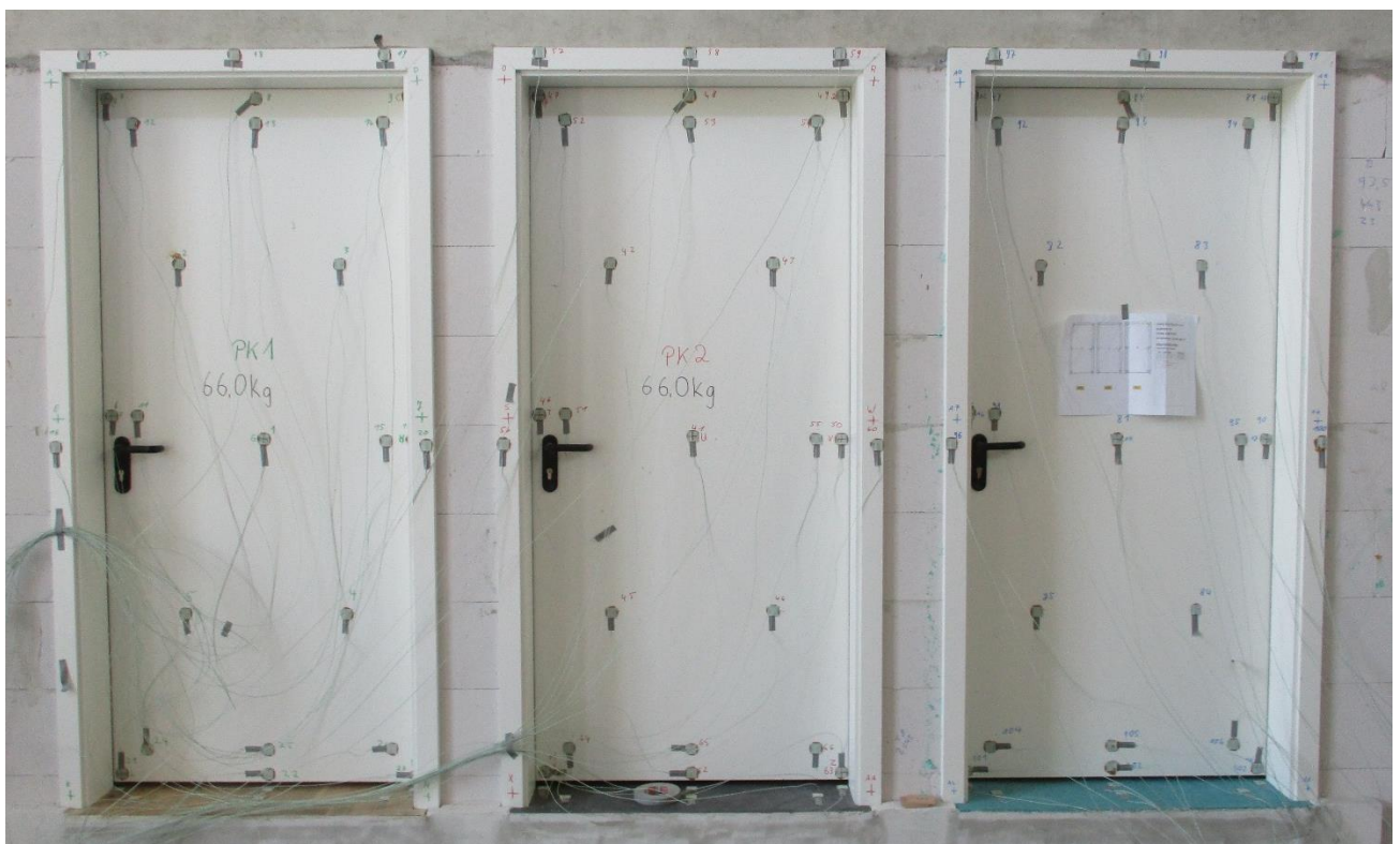
Abbildung 10: V 3 - Einbausituation der Prüfelemente
