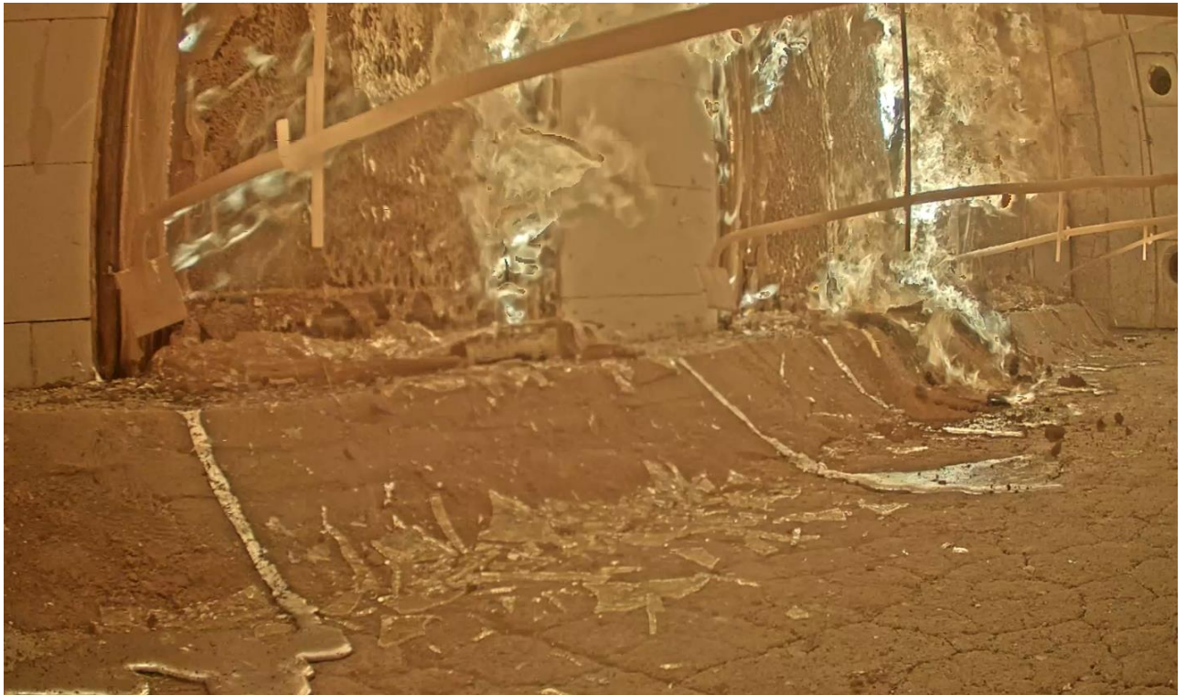
Abbildung 40: V 2 - Schwellenbereich nach dem Brandversuch (beflammte Seite)
