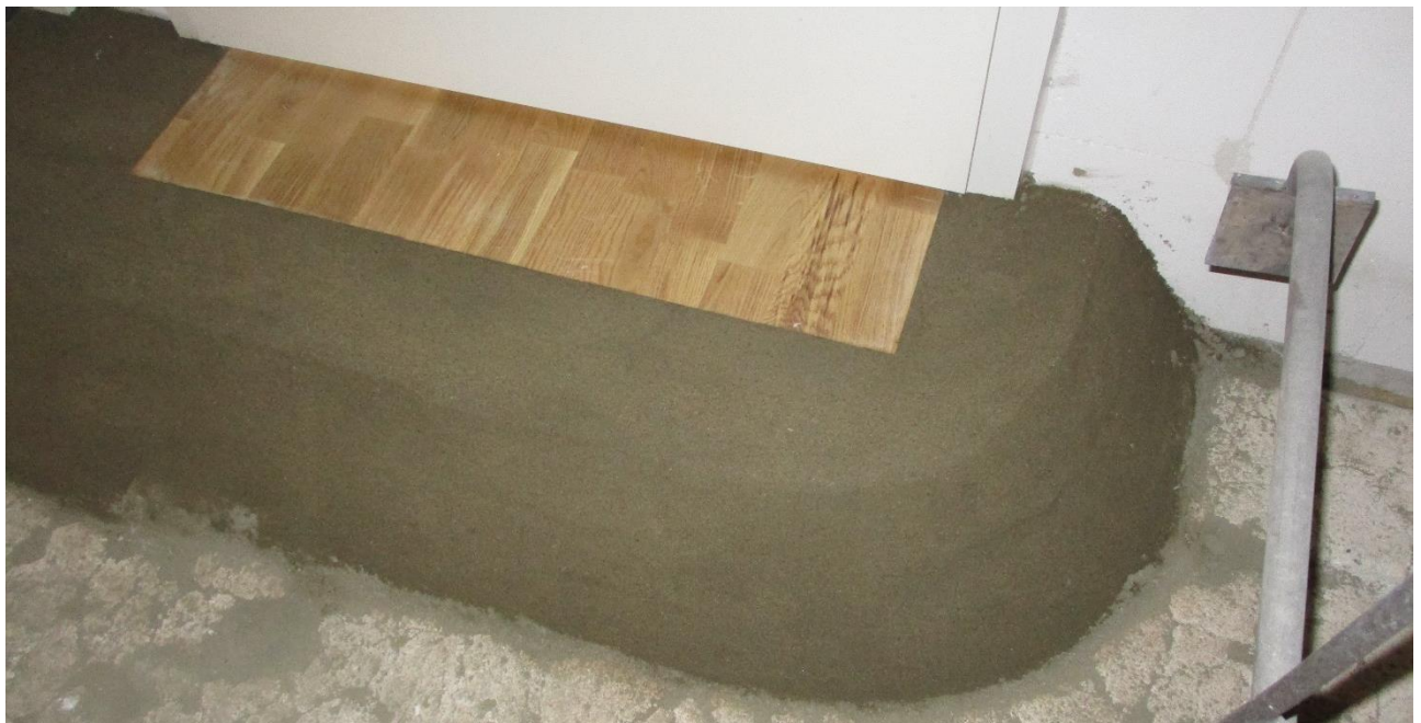
Abbildung 12: Exemplarische Darstellung der Kantenschutzmaßnahmen im Brandraum
