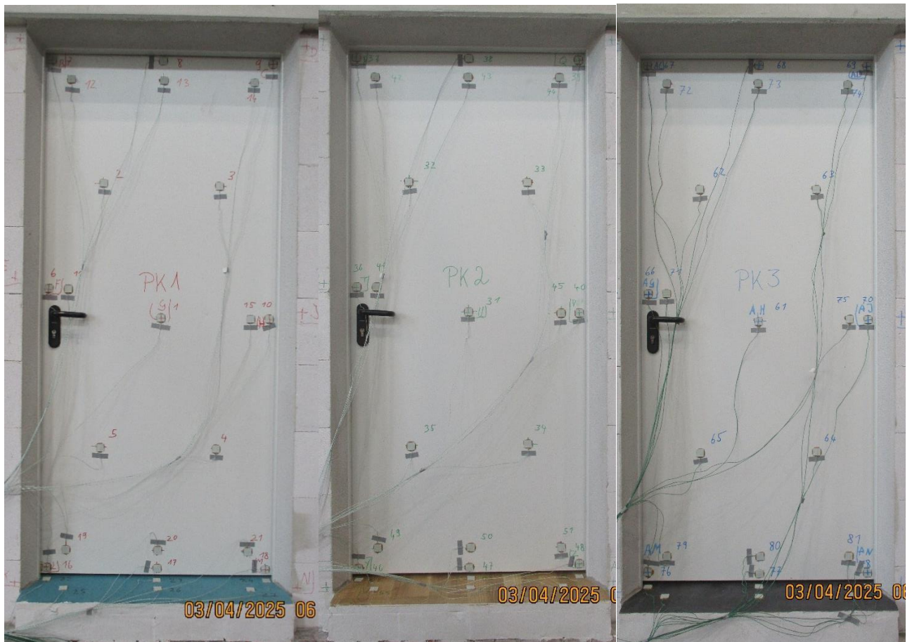
Abbildung 6: V 1 - Einbausituation der Prüfelemente
