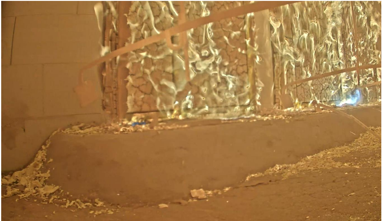
Abbildung 55: V 3 - Prüfelemente beflammete Seite nach Ende der Beflammung
