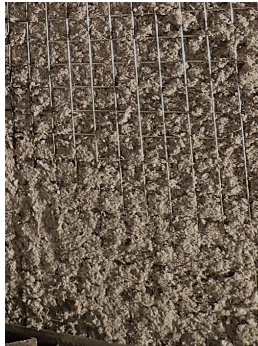
Foto 42: Probekörper Zt-L-L, Detailansicht des Gitters vor der Brandprüfung.
