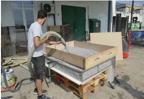
Abbildung 22: Einblasen des Dämmstoffs in den langen Flügel.
