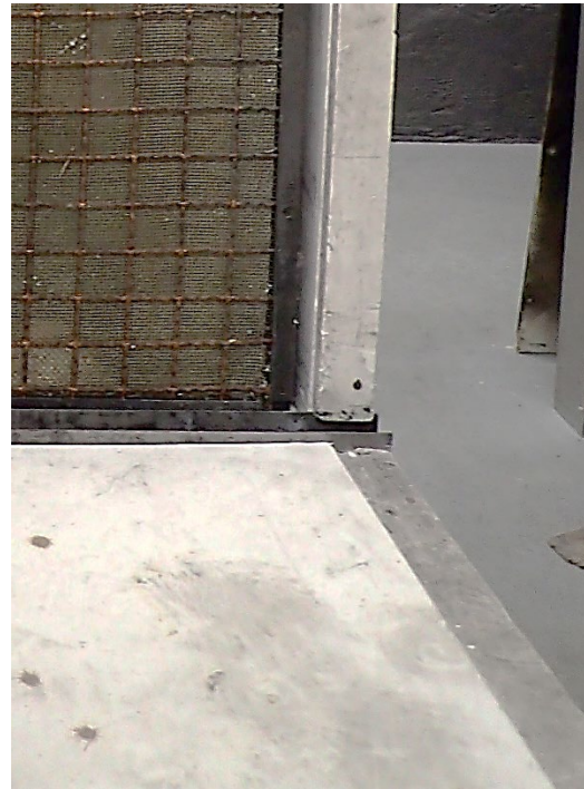
Foto 22: Probekörper MW-EU-EU, Detailansicht des Gitters vor der Brandprüfung.
