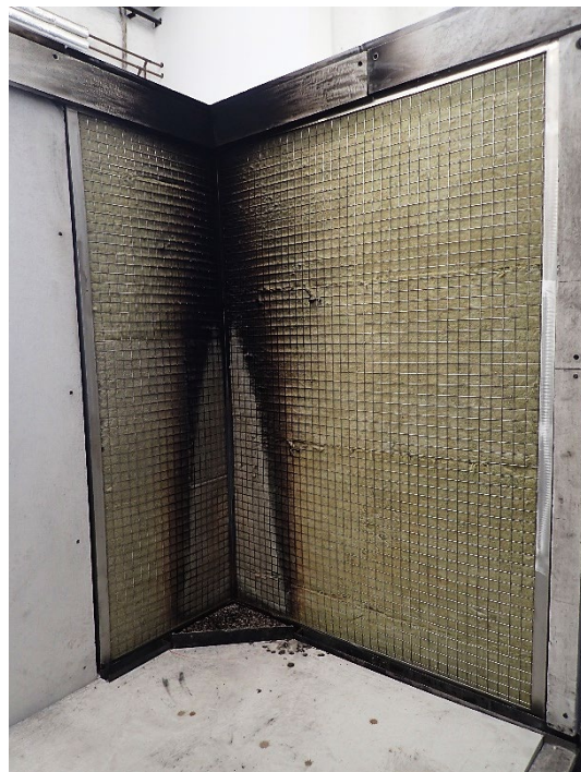
Foto 32: Probekörper MW-L-L, Ansicht nach der Prüfung.
