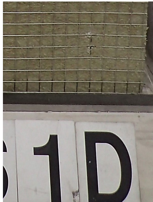
Foto 14: Probekörper MW-L-O, Detailansicht des Gitters vor der Brandprüfung.
