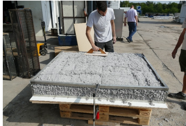
Abbildung 23: Festdrücken des eingeblasenen Dämmstoffs.
