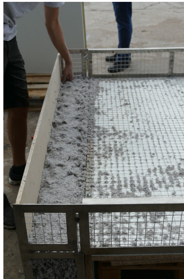
Abbildung 21: Verfüllen des kleinen Flügels des L-Korbs mit abgewogenen Zellulose-Dämmstoff.
