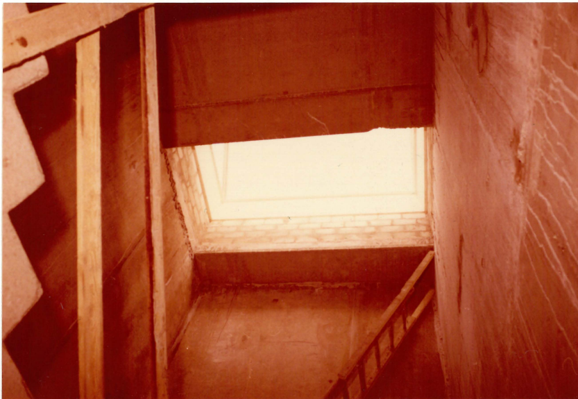
Bild 4 Rauchabzugsöffnung im Treppenraum Querschnitt 1,30 m x 2,37 m
