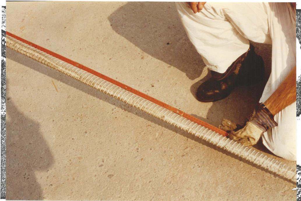
Bild 3.10 Verfüllter Spannkanal (PK 581-2)
