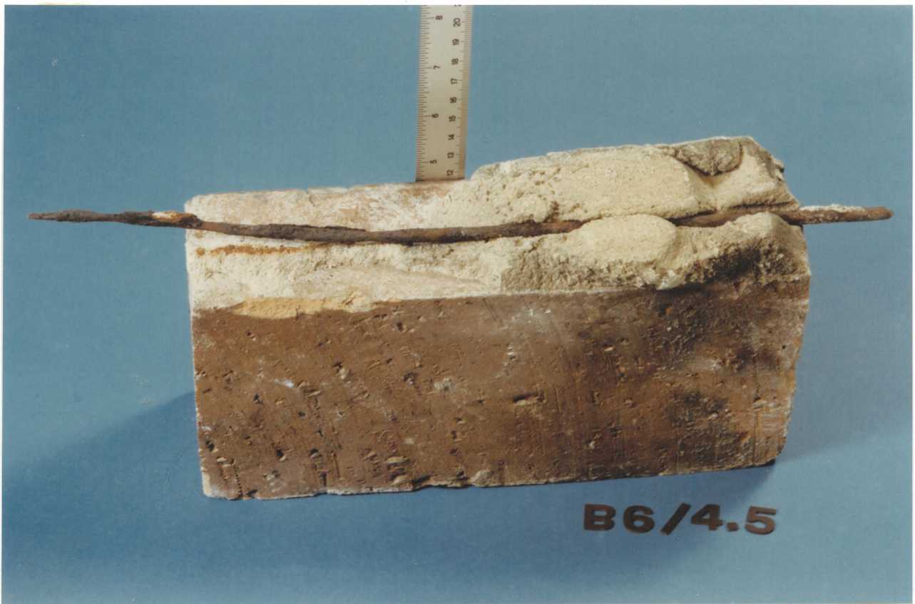
Bild 10. Ziegelprobe mit Mörtel und eingebetteter Bewehrung BAM-Proben-Nr. 9
