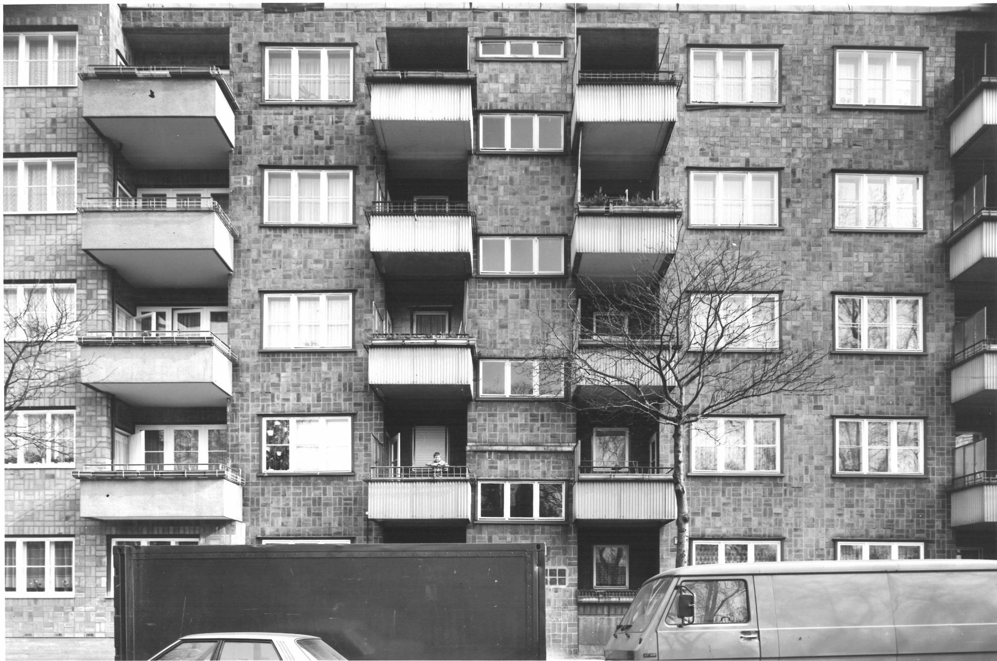
Bild 4. Ansicht der Verblendschale vor dem Abtrag
