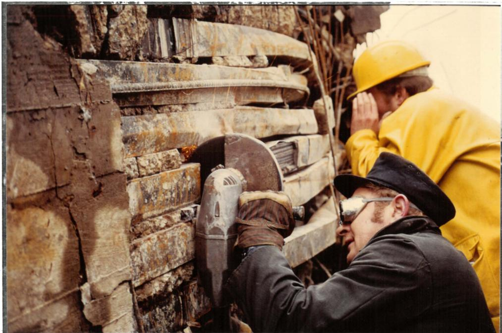
Abb. 36 Entnahme von Spanngliedabschnitten aus den Resten eines Hohlkastens
