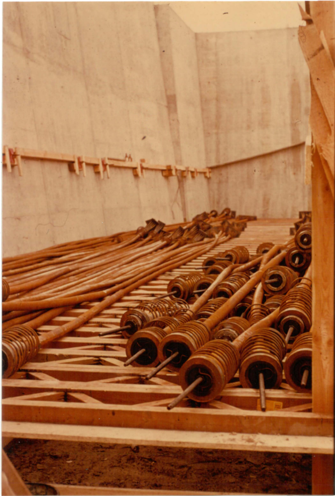
Abb. 15 Lagerung von Spann- gliedern (SUSPA) auf der Baustelle
