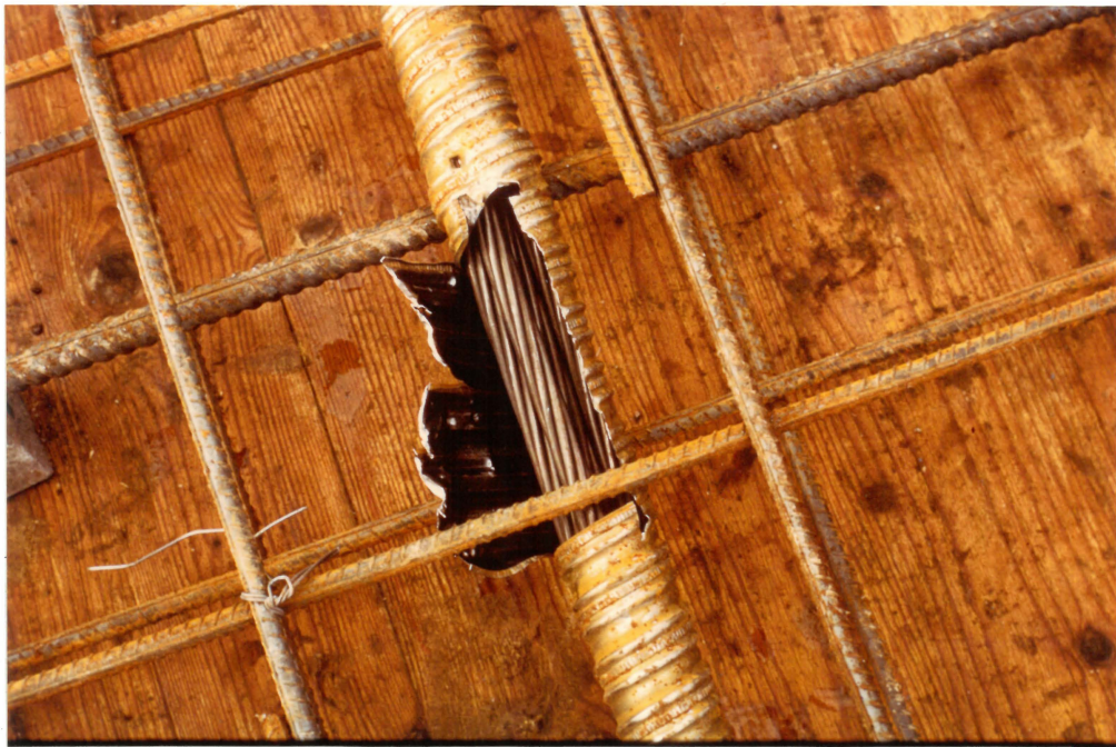
Abb. 54 Oberfläche der Litzen beim Verlegen
