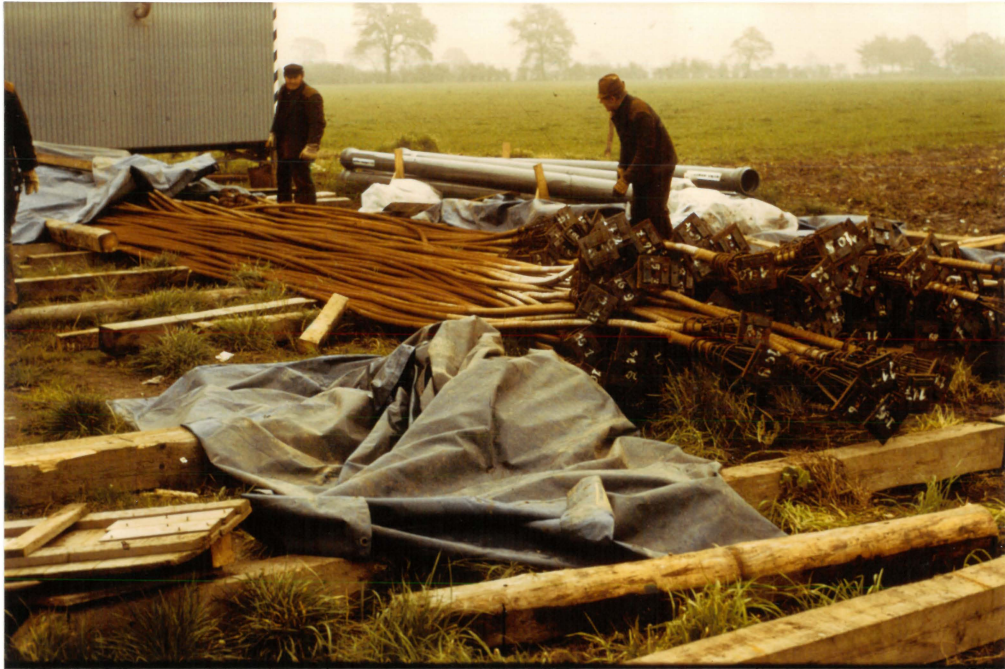
Abb. 17 Ungünstige Lagerung von Spanngliedern (SUSPA) auf der Baustelle
