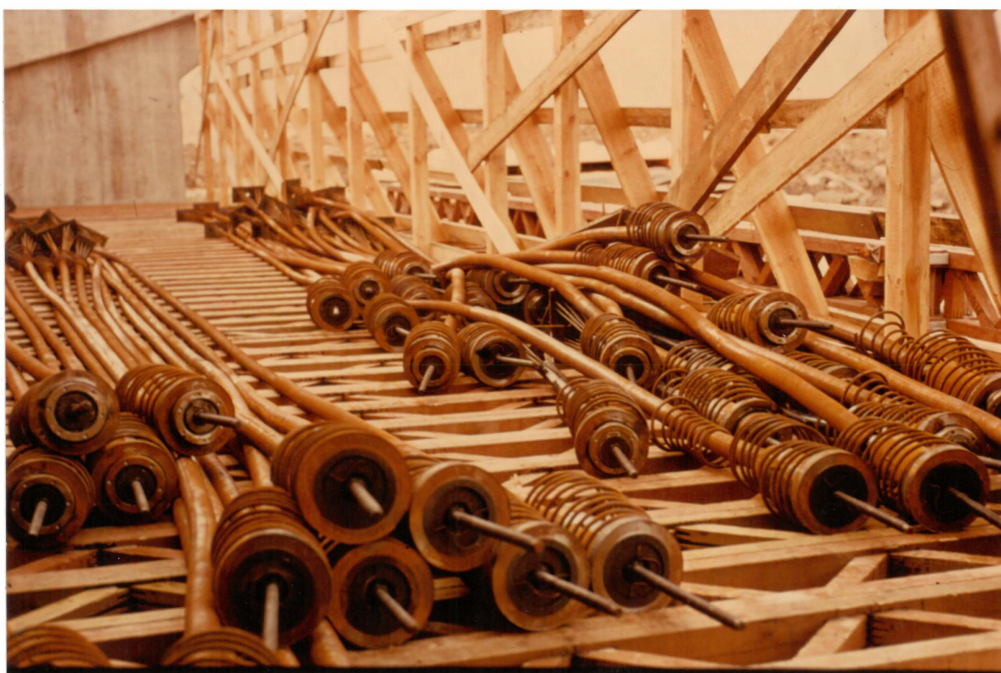
Abb. 14 Lagerung von Spanngliedern (SUSPA) auf der Baustelle
