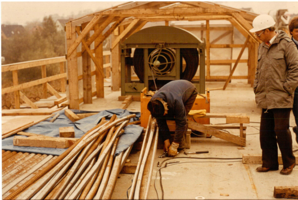
Abb. 22 Einziehen von Spannstahllitzen in Hüllrohre auf der Baustelle
