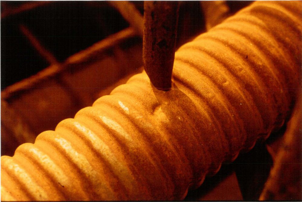
Abb. 39 Knick am Hüllrohr
