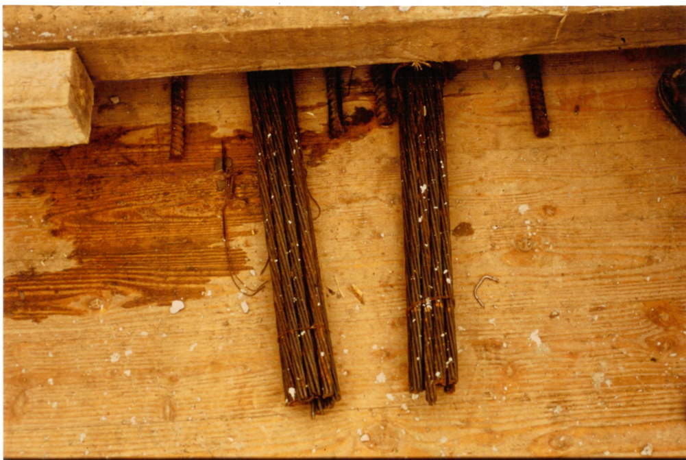
Abb. 33 Freiliegende Koppelstellen
