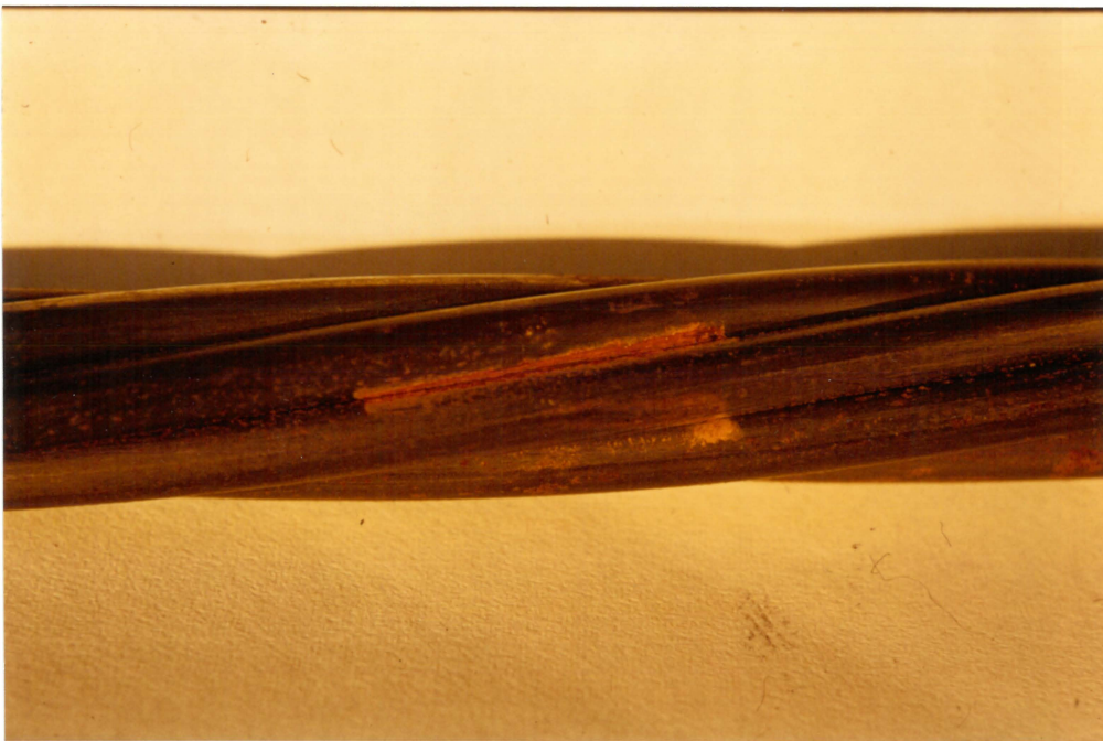
Abb. 20 Korrosion im Zwickelbereich von Litzen
