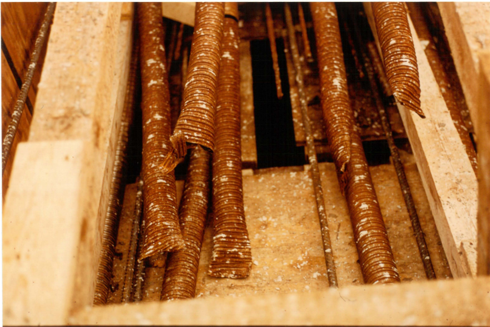
Abb. 32 Freiliegende Koppelstellen
