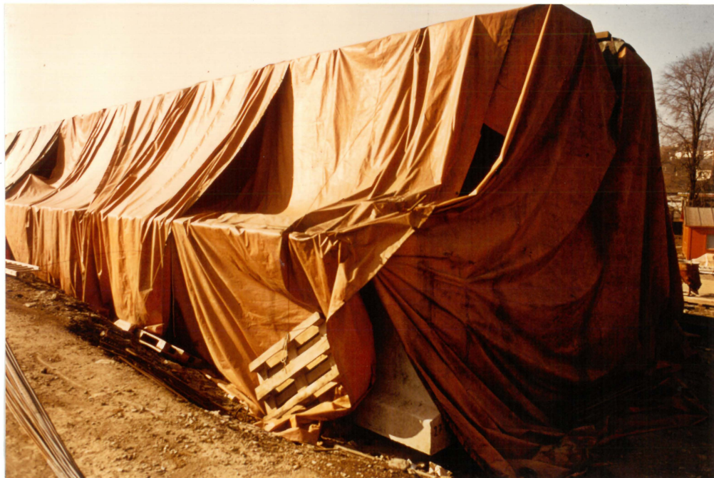
Abb. 44 Abdeckung des Fertigteilträgers
