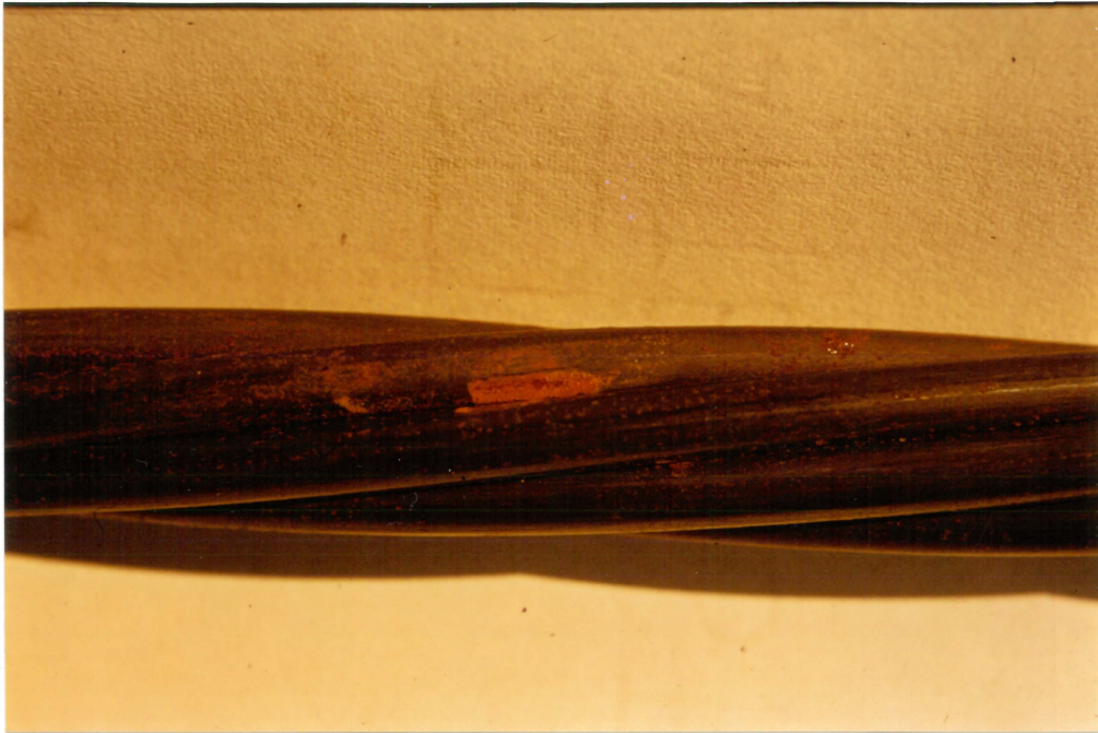
Abb. 19 Korrosion im Zwickelbereich von Litzen
