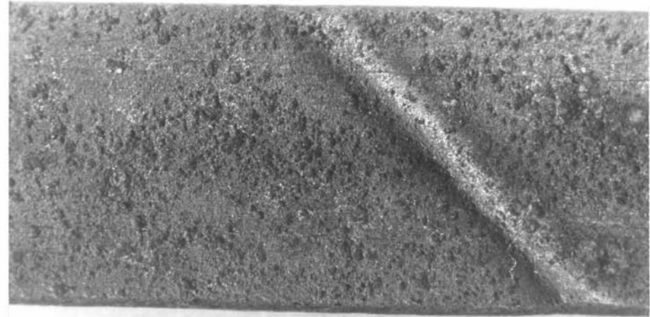
2 Oberfläche mit punktförmiger Korrosion
