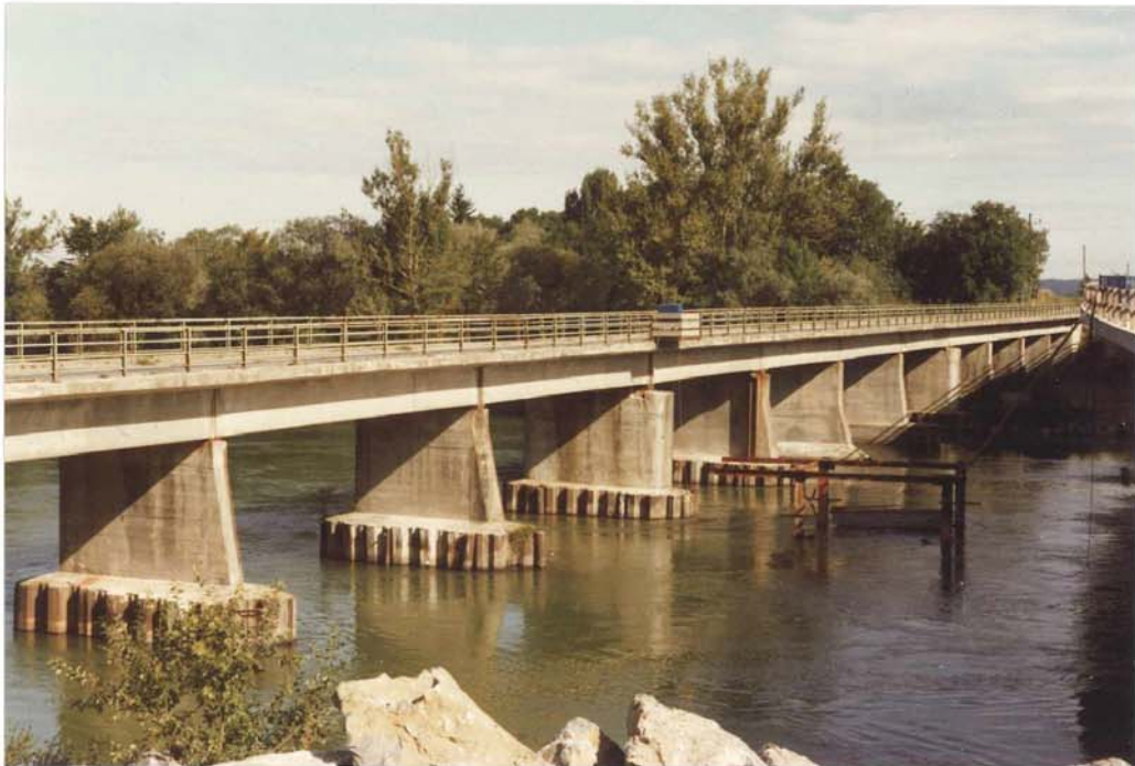
Bild 4. Gesamtansicht der Brücke gegen das östliche Widerlager
