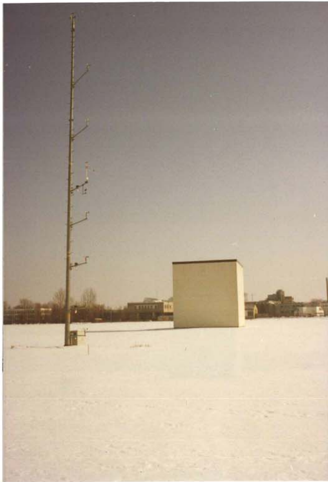
Abb. 1: Ansicht des Versuchsgebäudes Osten (oben) und von Westen
