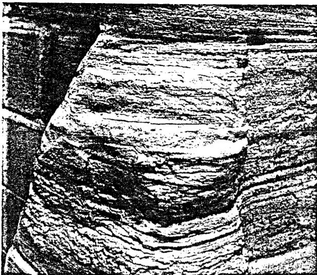
Abb. 3.2: Starker Materialabtrag durch Verwitterung
