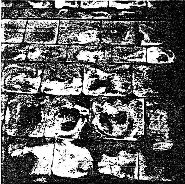
Abb. 3.3: Ausblühungen auf einer Sandsteinfassade nach Schlagregenbelastung
