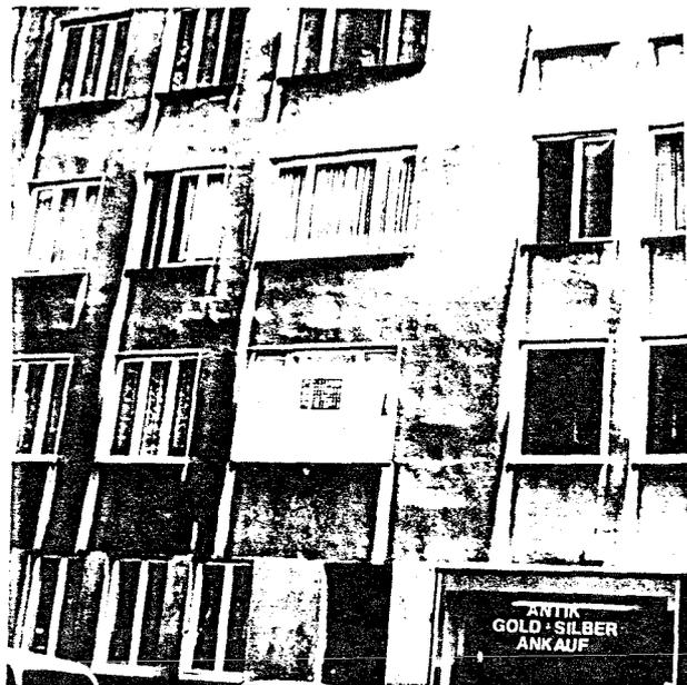
Abb. 3.15: Ungleichmäßige Verschmutzung einer Putzfassade
