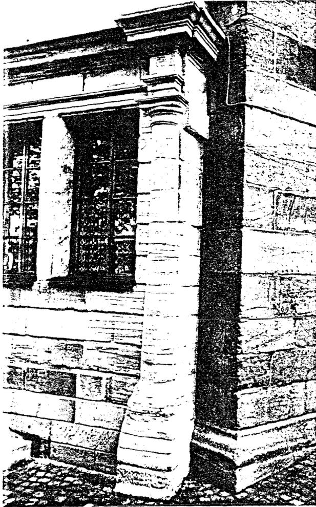
Abb. 3.1: Unterschiedliche Verwitterung von Natursteinmauerwerk, geschützt und freiliegend
