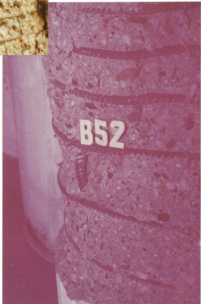
Bild 18 : Manchmal zu beobachtende Begleit- erscheinung nach Erreichen der Systembruchlast bei den Probekörpern \varnothing 480 mm: Ausknicken der Längs- bewehrung im weniger umschnürten Bereich
