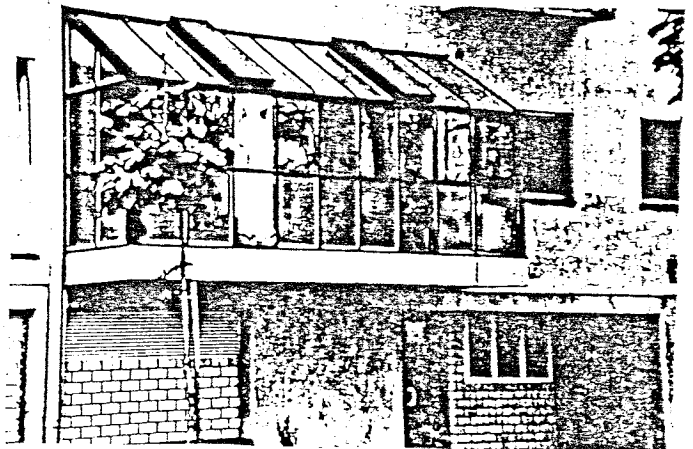
Abb. 58: Erker mit durchsichtig verglastem Brüstungselement, das auch Kleinkindern den Blick auf die Straße ermöglicht.
