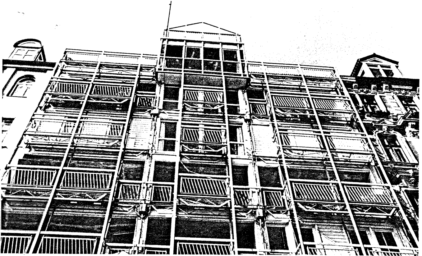
Fassadenausschnitt mit Anschluß an die Nachbarbebauung
