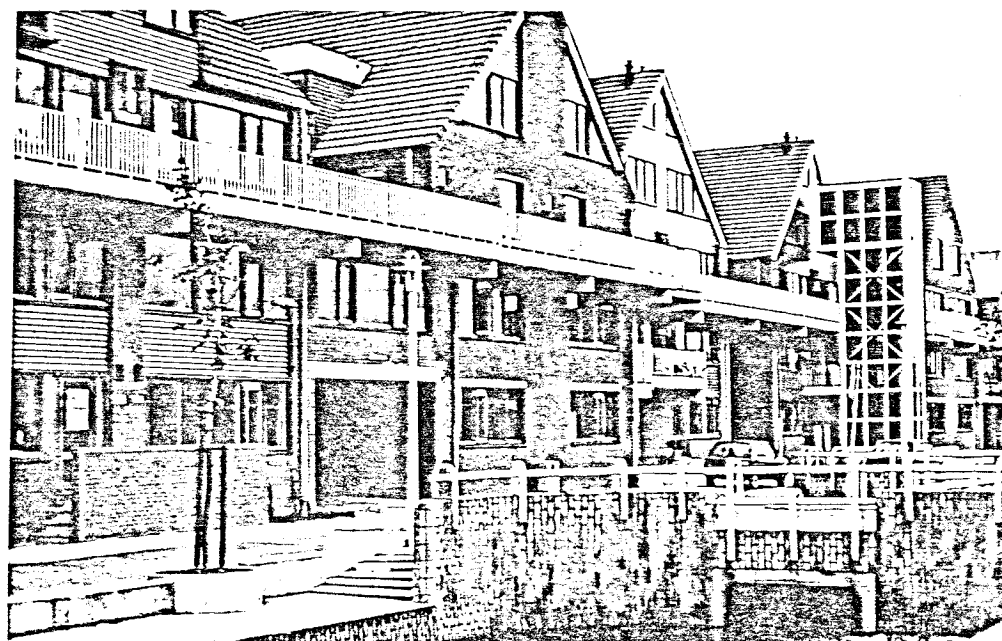
Über einen vorgelagerten, geschlossenen Treppenhausturm wurden die im 2. Obergeschoß gelegenen Maisonette-Wohnungen erschlossen.
