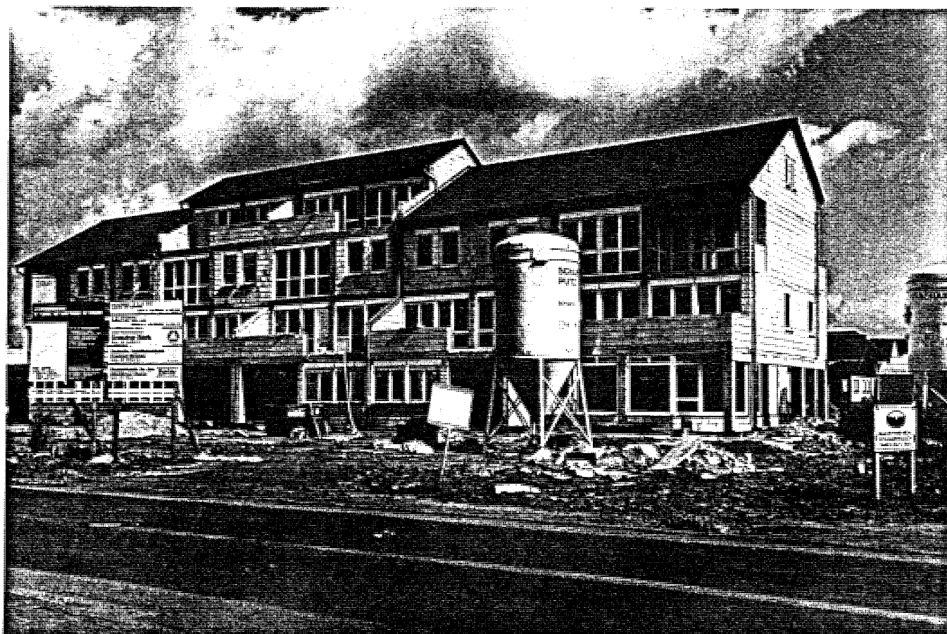
Gartenseite des Hauses während der Bauausführung
