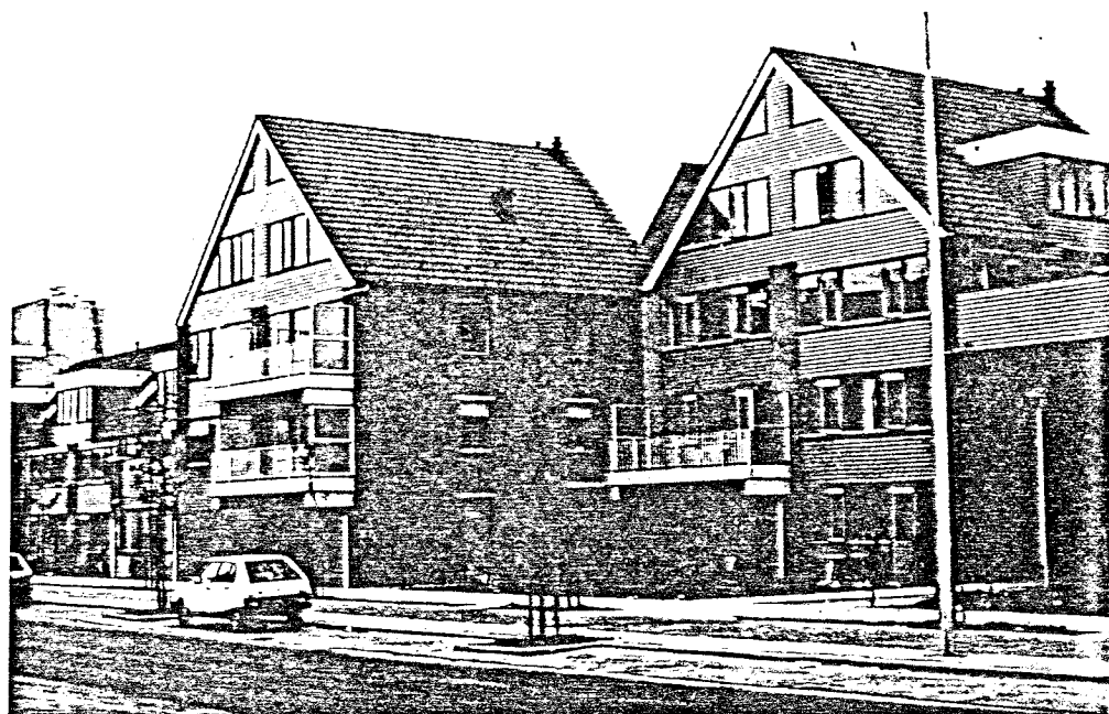
Ansicht der gestaffelten Geschoß- und Einfamilienreihenhausbebauung von der Wohnstraße aus.
