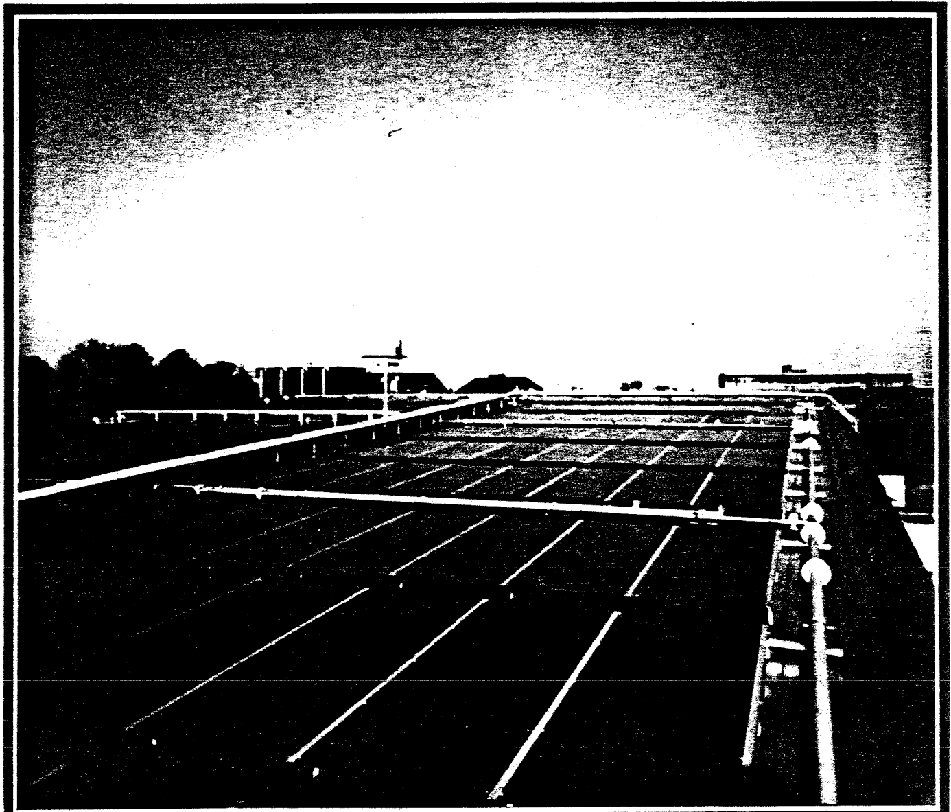
KSH Schwalmtal Energie-Dach aus 204 Absorberplatten u. Soler- teilungsleitungen auf dem Dach d. Schwimmhalle
