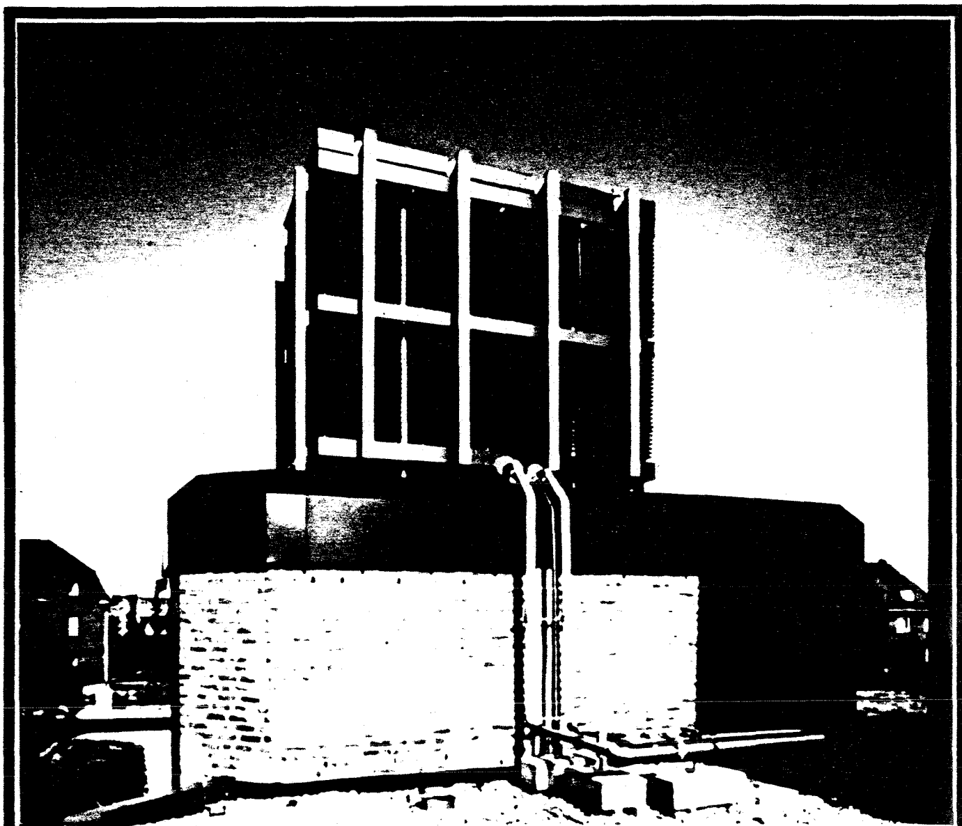
KSH Schwalmtal Energie-Stapel aus 8 Blöcken mit je 24 Absorber- platten auf dem Dach des Treppenhauses
