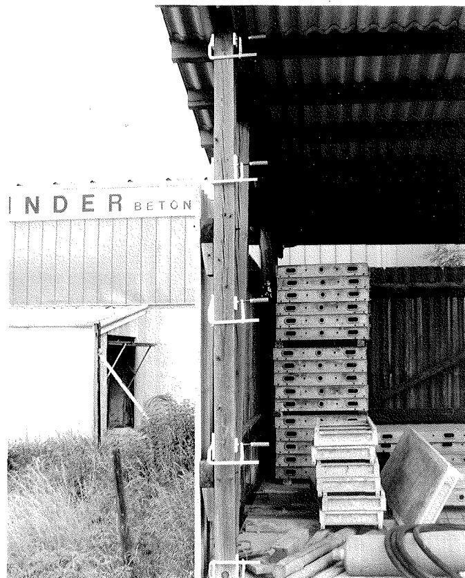
Bild 15: Stütze mit Meßmarken in einem Lagerschuppen
