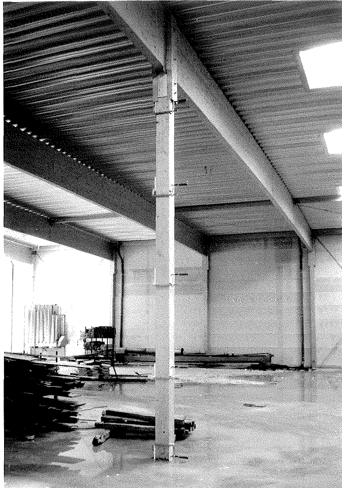
Bild 14: Stütze mit Meßmarken in der Lagerhalle
