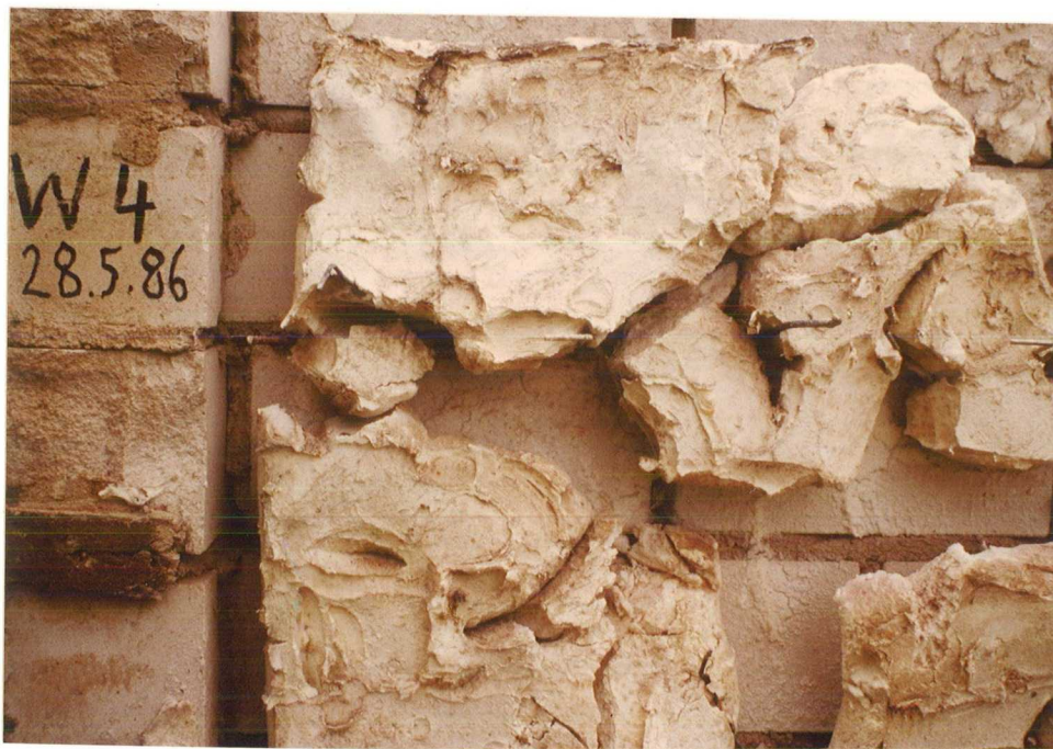
Bild 6: Teilansicht des UF-Schaumes "E" in Wand 4 nach Entfernen der Vormauerschale
