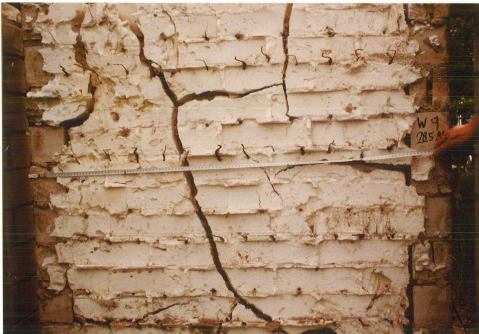
Bild 10: Ansicht des UF-Schaumes "D" in Wand 9 nach Entfernen der Vor- mauerschale
