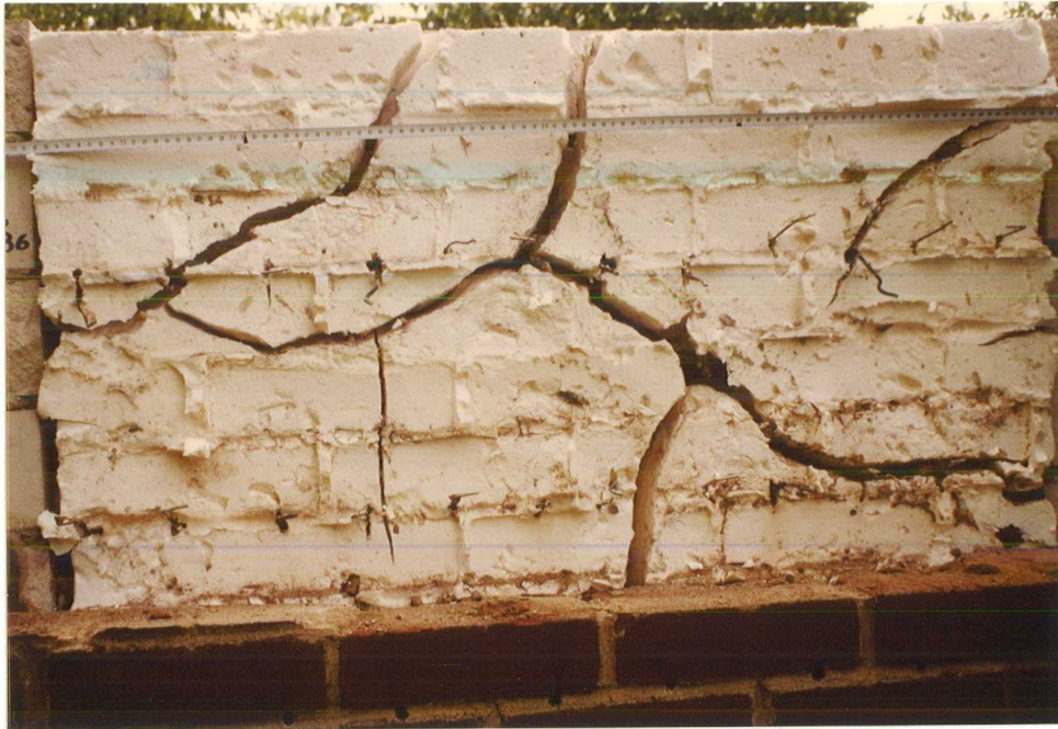
Bild 3: Teilansicht des UF-Schaumes "B" in Wand 2 nach Entfernen der Vormauerschale
