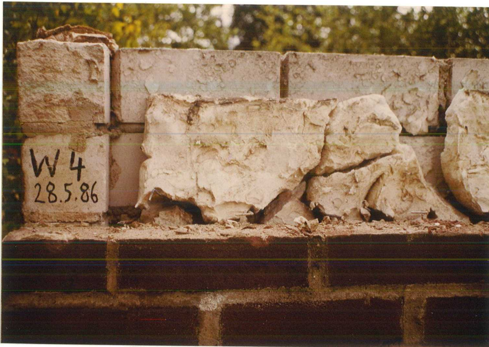
Bild 5: Teilansicht des UF-Schaumes "E" in Wand 4 nach teilweisem Entfernen der Vormauerschale
