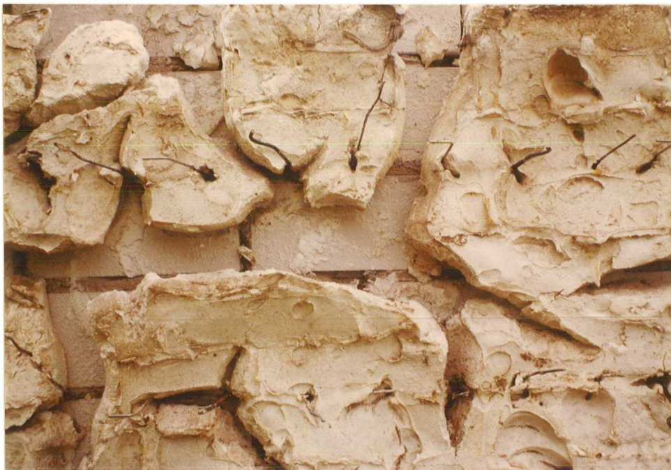
Bild 8: Teilansicht des UF-Schaumes "E" in Wand 4 nach Entfernen der Vormauerschale
