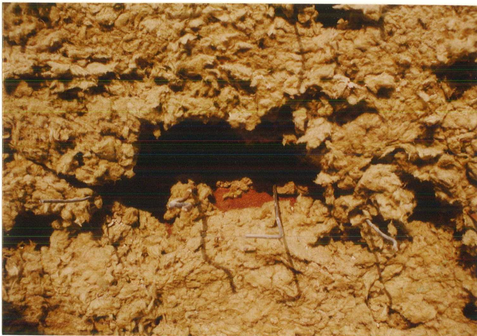
Bild 12: Teilansicht der Schüttung C in Wand 19 nach Entfernen der Hintermauerung
