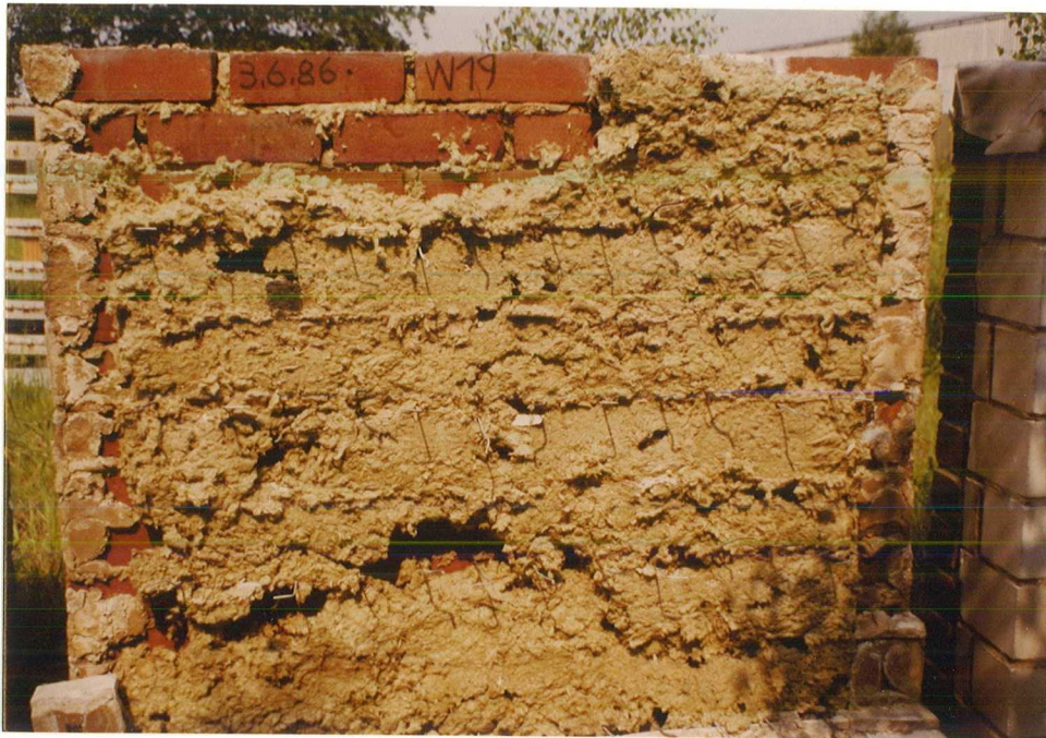
Bild 11: Ansicht der Schüttung C in Wand 19 nach Entfernen der Hintermauerung
