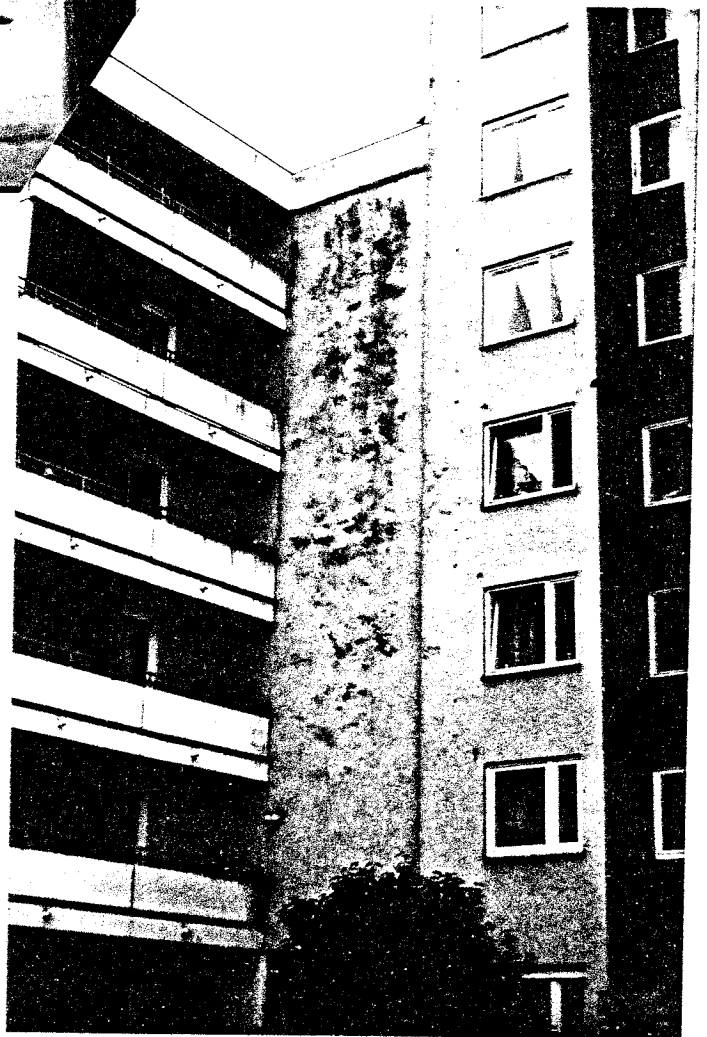
109 Durchfeuchtungsschäden an der Fassade
