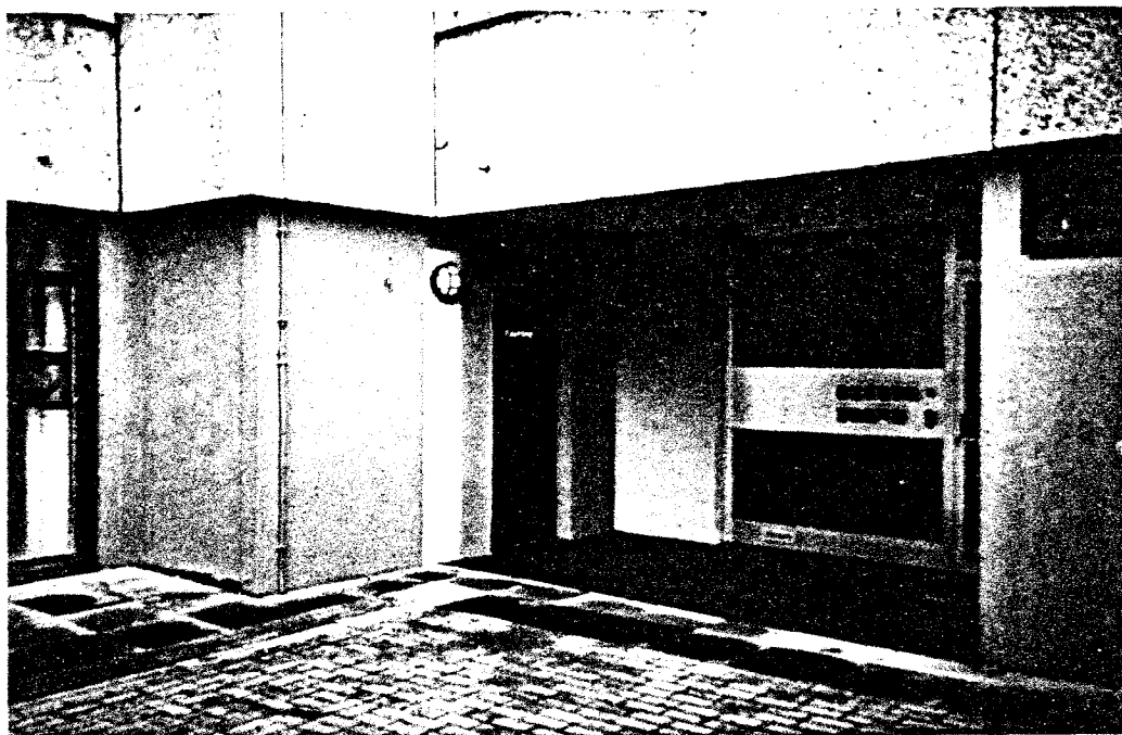
84 Unterdimensionierter, versteckter Hochhaus-Eingang
