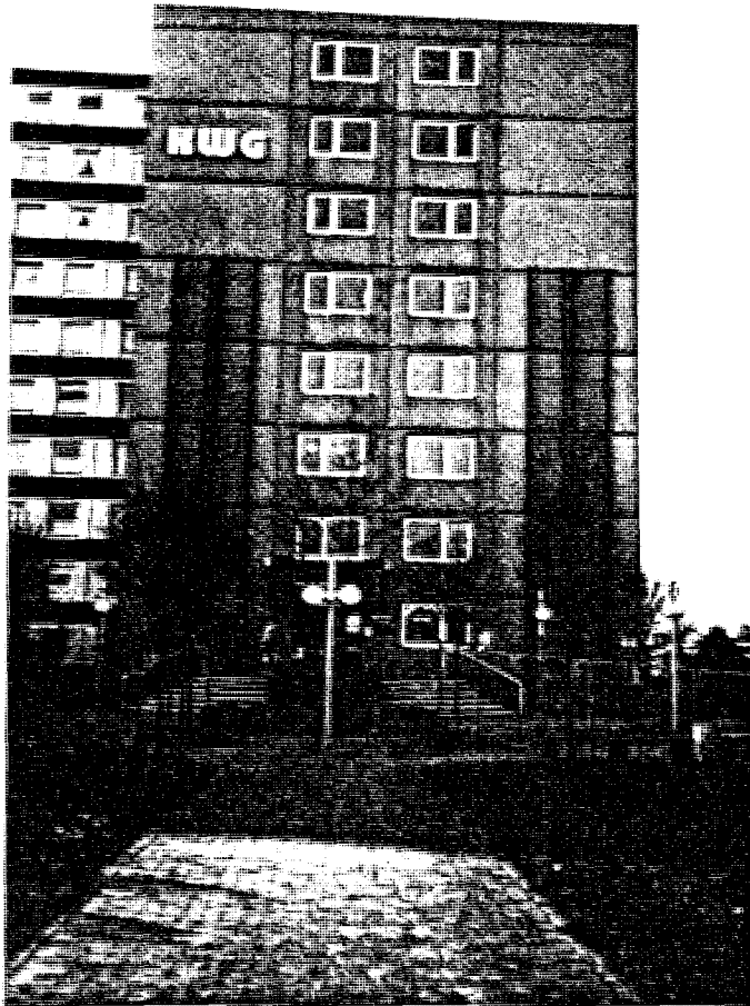
77 Umnutzung eines Wohnhauses in ein Bürogebäude für das Wohnungsunternehmen (Kiel-Mettenhof)
