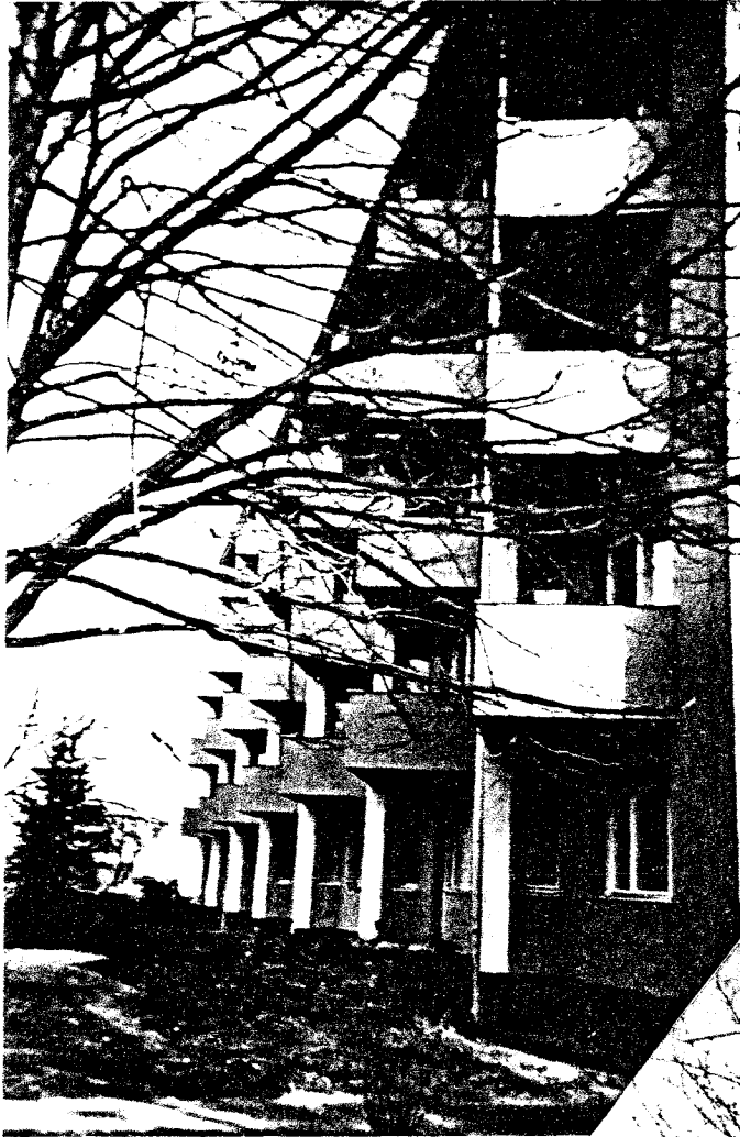
116 ...und nach Rückbau und Sanierung
