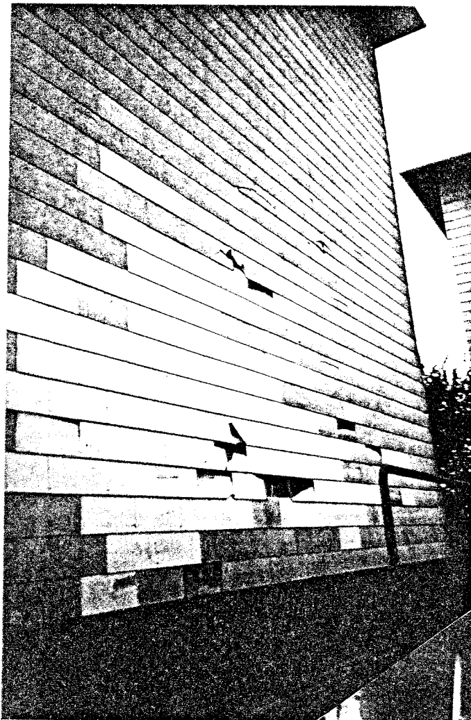
5 Bauschäden an der Fassadenverkleidung
