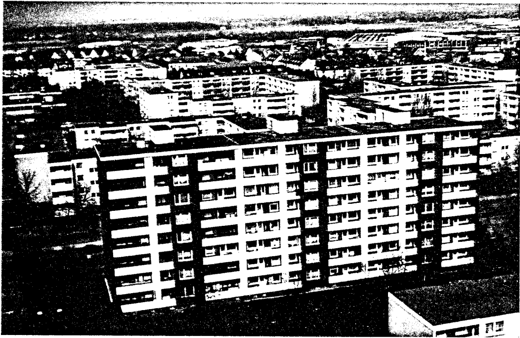
41 in Teilbereichen stark verdichtet (Bremen-Obervieland)
