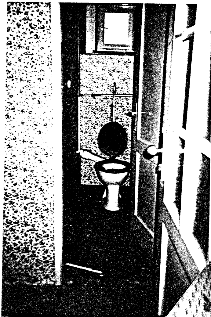
15 WC vor der Modernisierung
