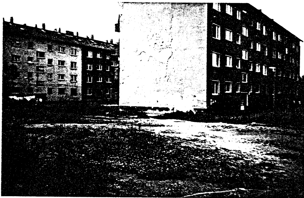
33 Bauschäden an den Fassaden
