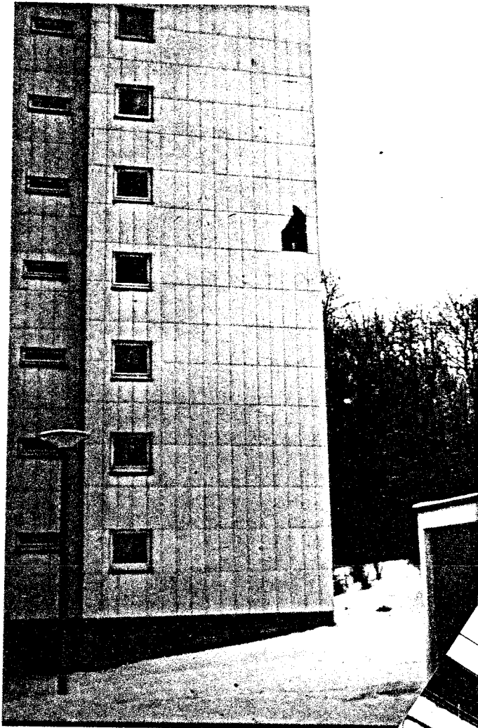
108 Schäden an der Platten- verkleidung der Fassade
