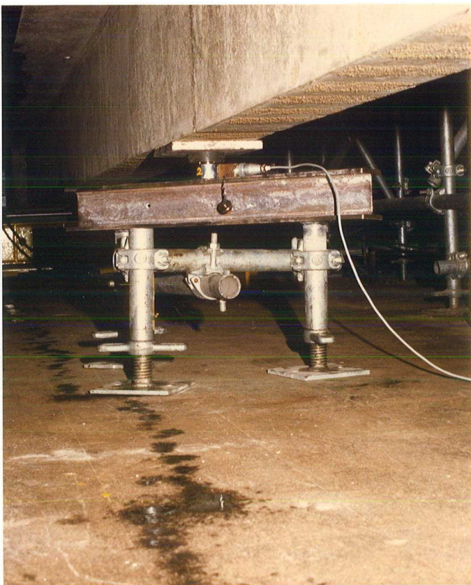
Bild 3.20: Konstruktion der Hilfsauflager
