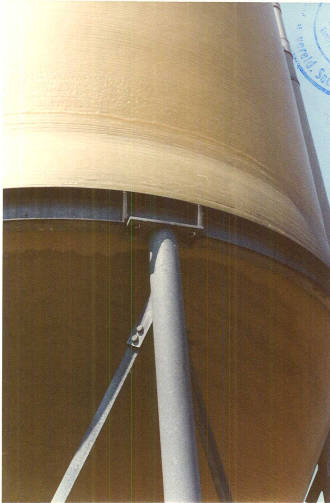
Bild 54 Auflagerung auf Stahlring (Schnitt: Bild 41)
