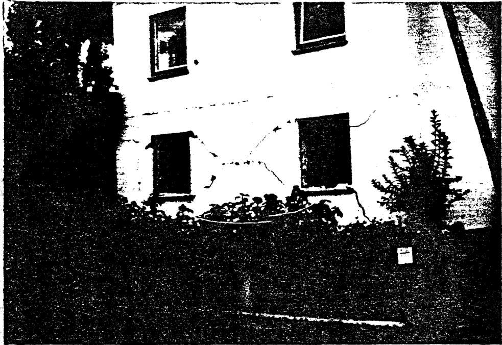
Weidenstraße 37 - Südostgiebel Typische Kreuzrisse aus der Schubbeanspruchung
