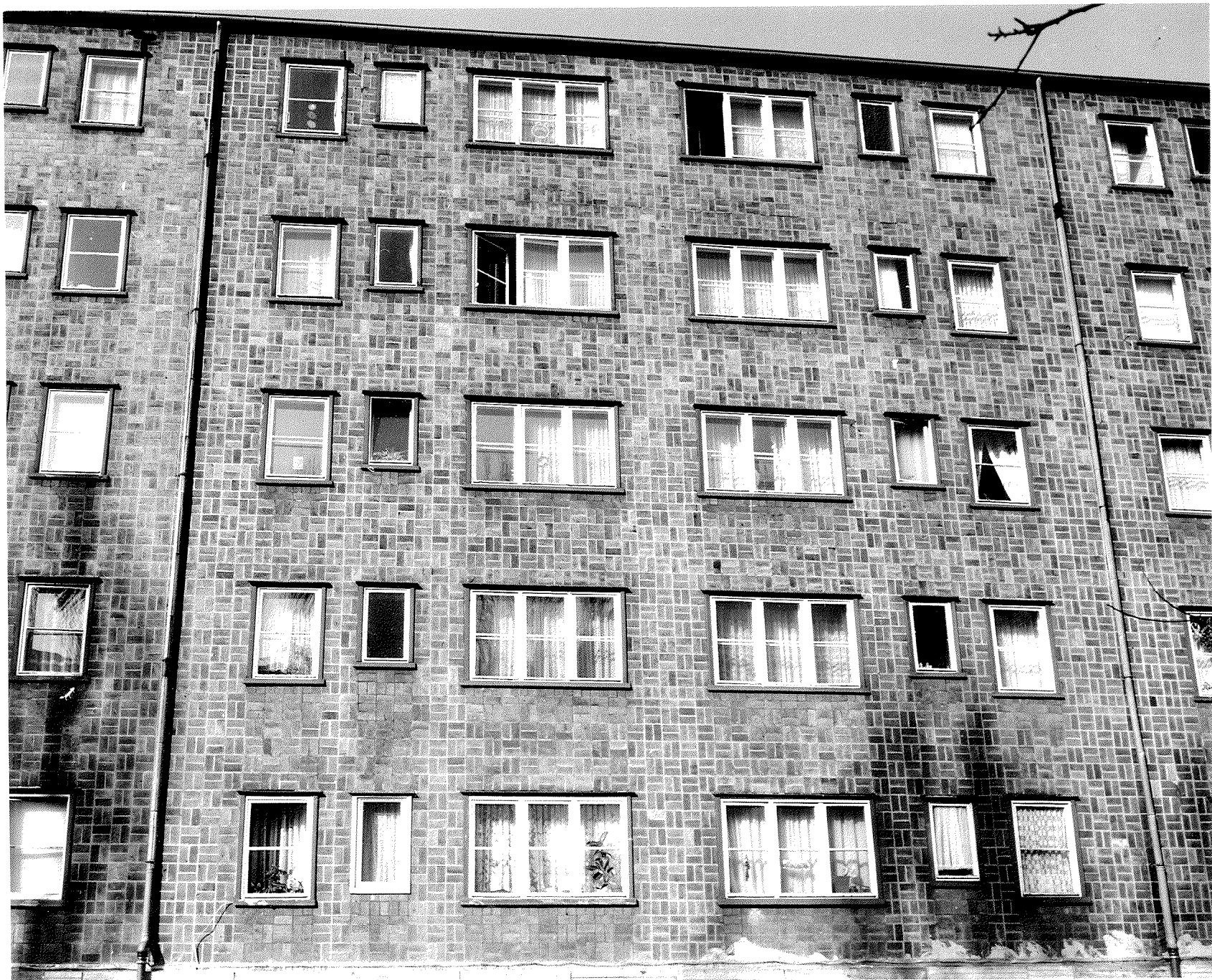
Bild 4. Ansicht der Verblendschale vor dem Abtrag
