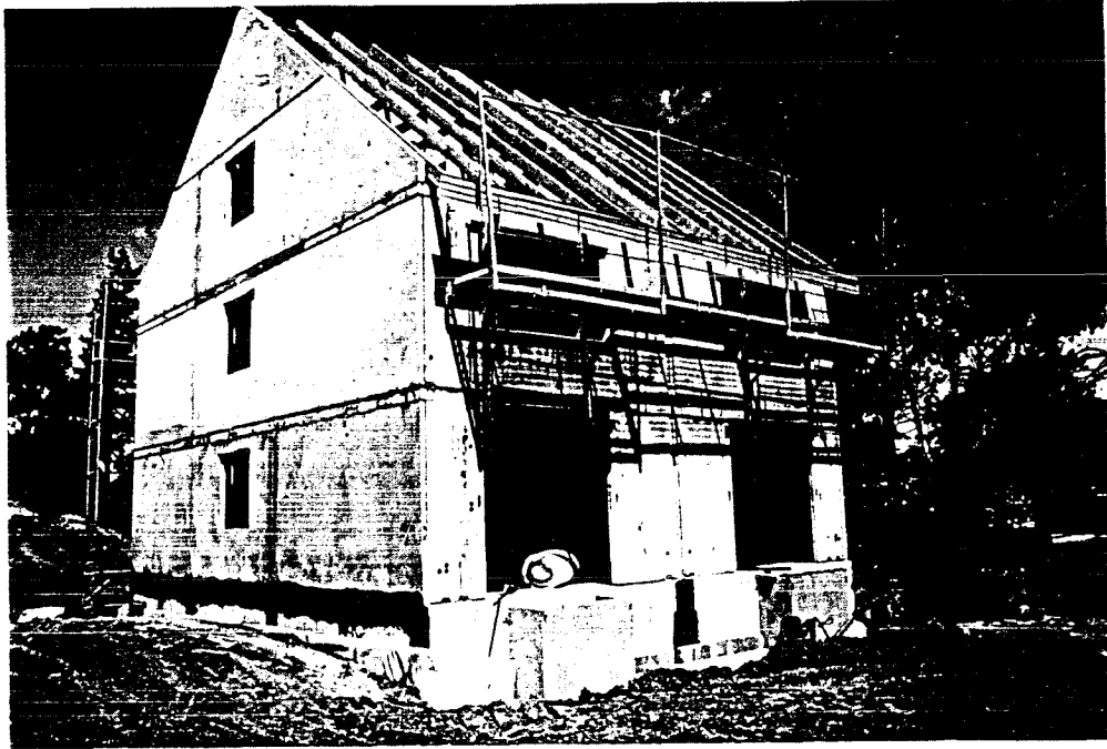
Bild 1: Reihenhaushaus im Rohbau
