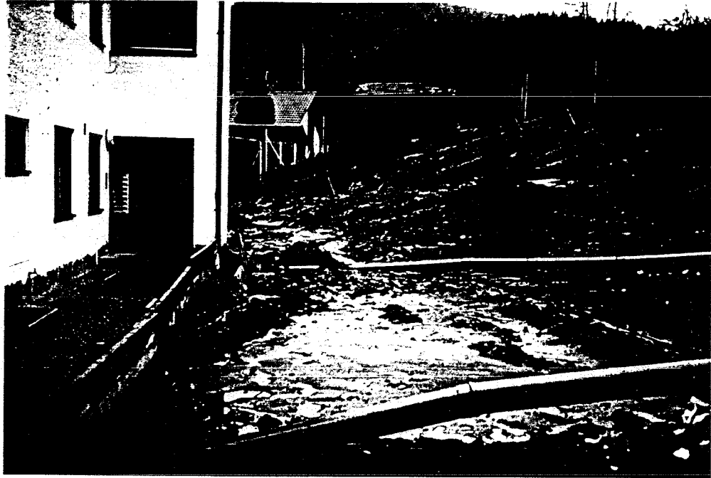
Bild 17: Provisorische Ableitung des Hangwassers
