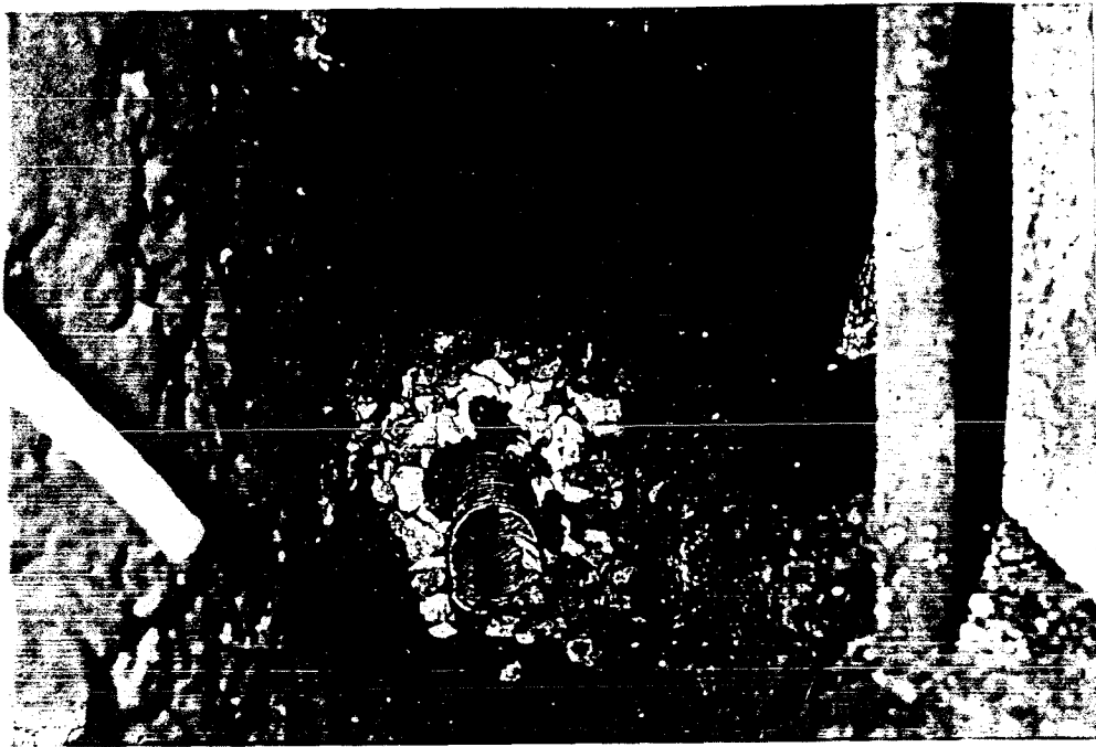
Bild 3: Dränschlauch mit Kalkschotterummantelung
