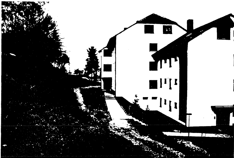
Bild 23: Hangbereich nach der Sanierung
